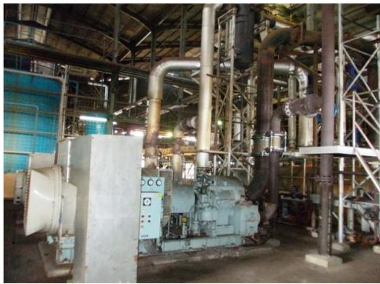
圖47、以殘餘物燃燒發電的發電設備
