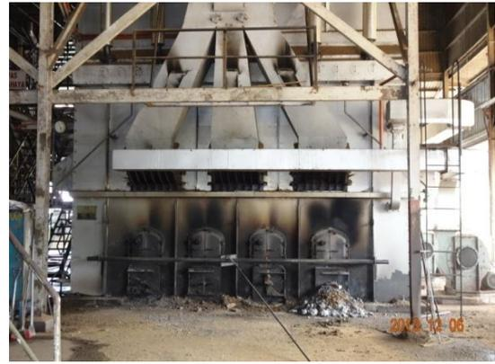
圖46、以殘餘物作燃料的發電機鍋爐
