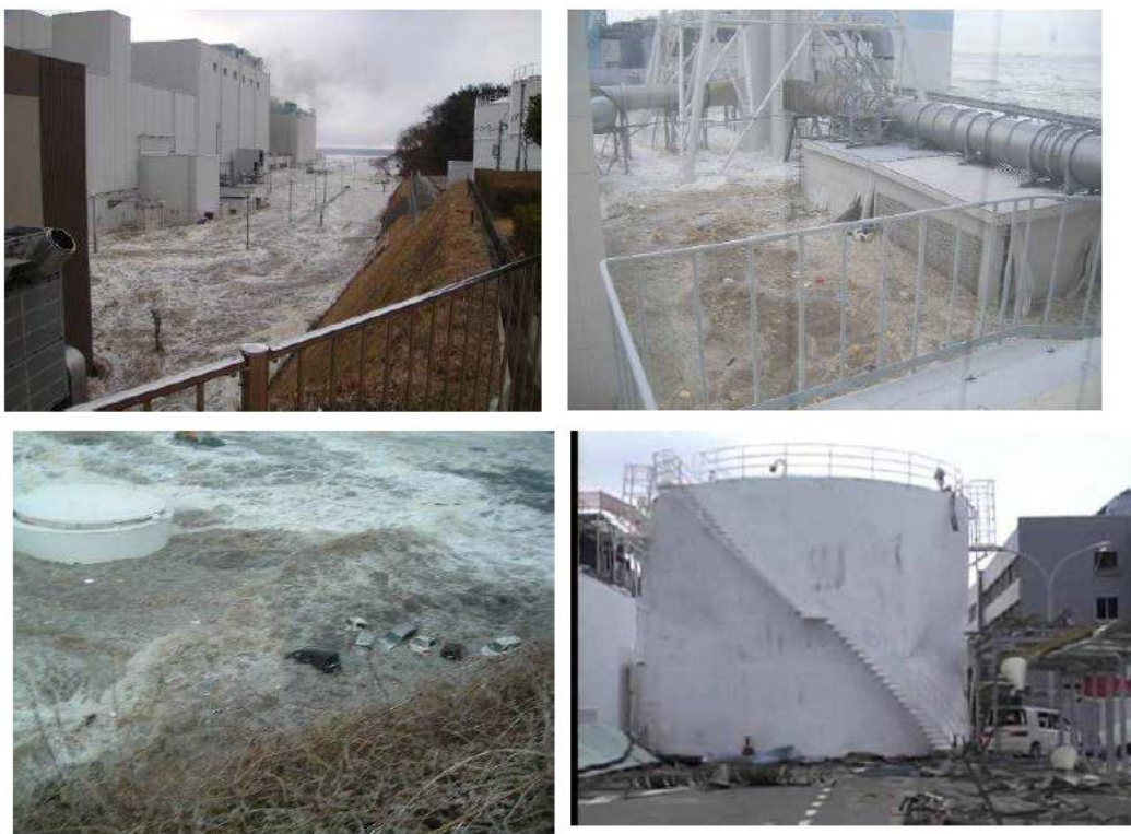
圖 2-6、海水淹沒核電機組廠房及破壞情形
