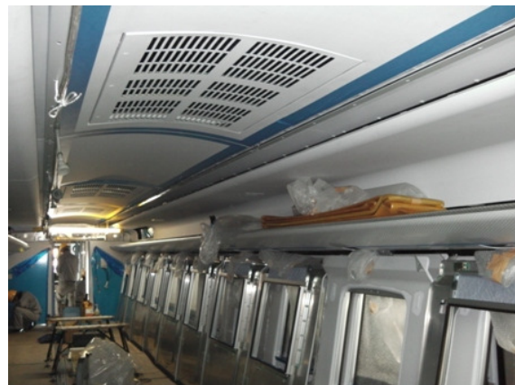
圖10 車內側牆內裝板安裝
