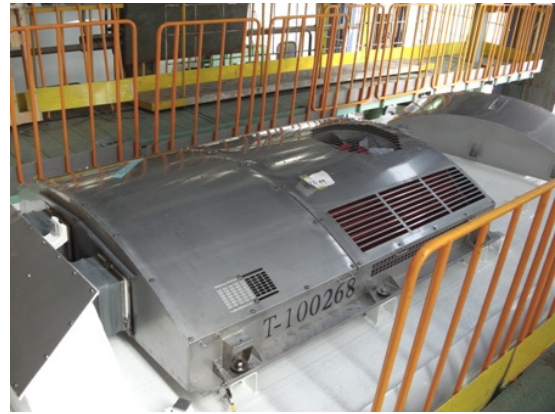
圖6 空調機更換作業完成
