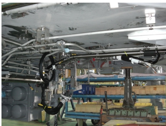
圖45 車下管路配線安裝
