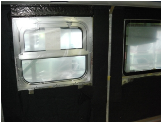
圖7 車內側窗區裝隔音材
