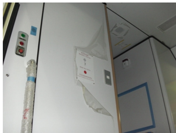
圖28 緊急對講機電裝作業
