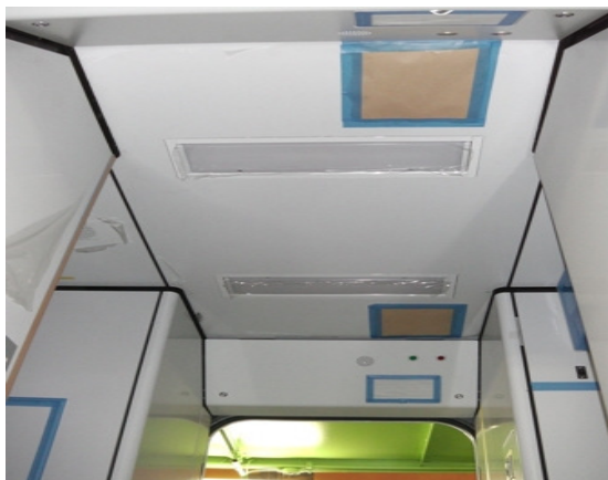
圖27 上下台區內裝板安裝
