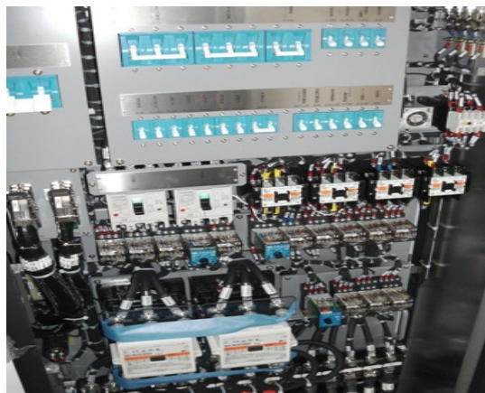
圖25 車廂配電盤電裝作業
