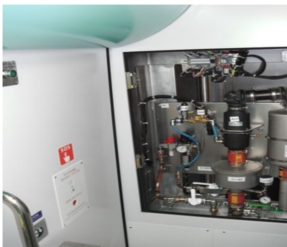
圖39 真空式廁所設備安裝
