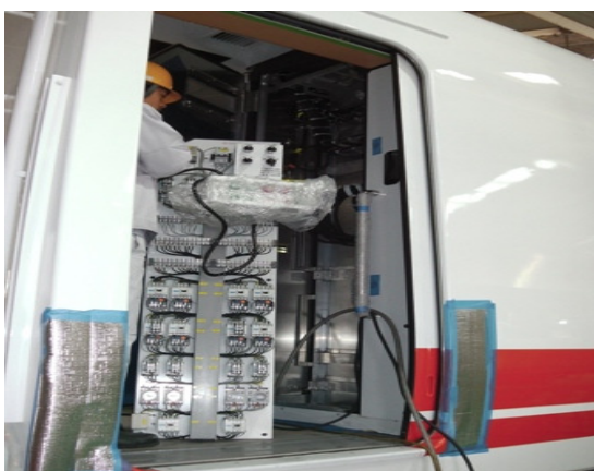
圖43 空調機控制盤安裝
