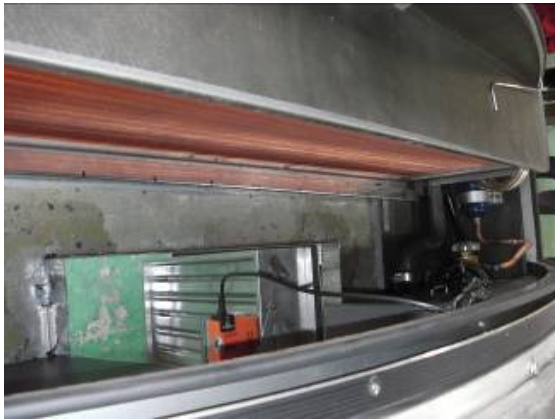
圖1 空調機蒸發器基座焊接隔板
