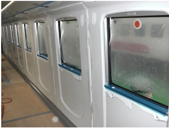
圖11 車內側牆內裝板安裝完成
