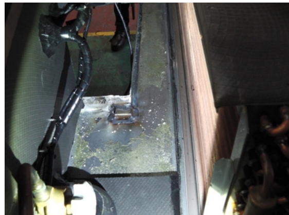
圖2 空調機螺絲蓋板焊接
