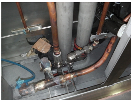
圖38 廁所設備管路焊接
