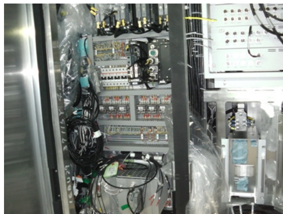
圖26 駕駛室電裝作業
