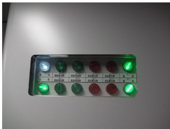
圖97 空調機盤供電測試
