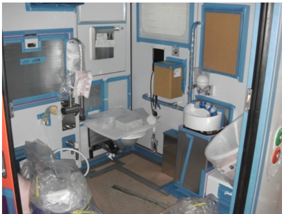
圖33 TED車無障礙廁所設備安裝
