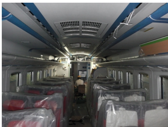
圖35 座椅設備安裝
