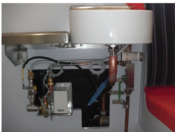
圖37 哺集乳室洗手台設備安裝
