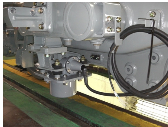
圖58 TEP車APC天線安裝
