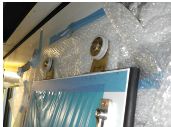
圖102 客室通道門安裝
