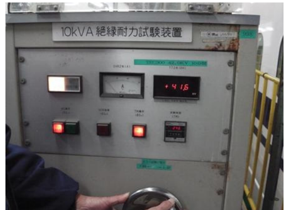
圖88 耐壓設定41.6KV試驗
