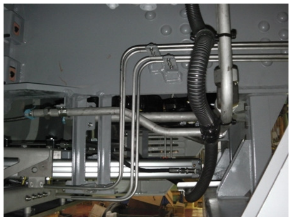
圖46 車下管路配置安裝
