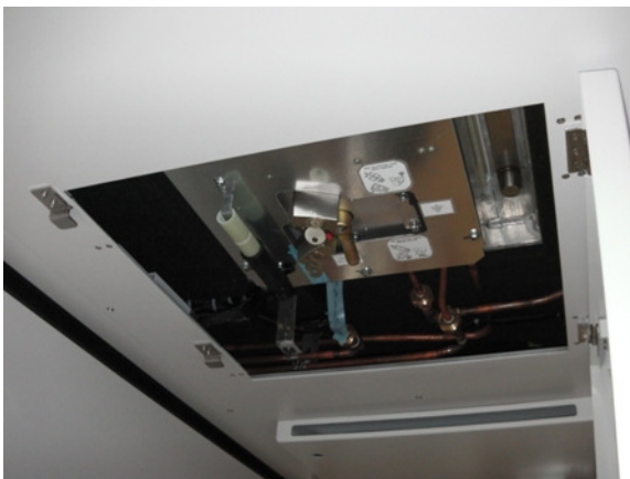
圖21 TEP車接地開關區內裝版安裝
