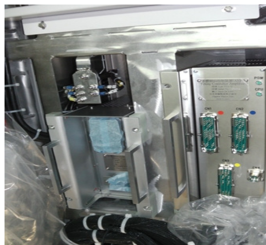
圖40 車體傾斜控制設備安裝
