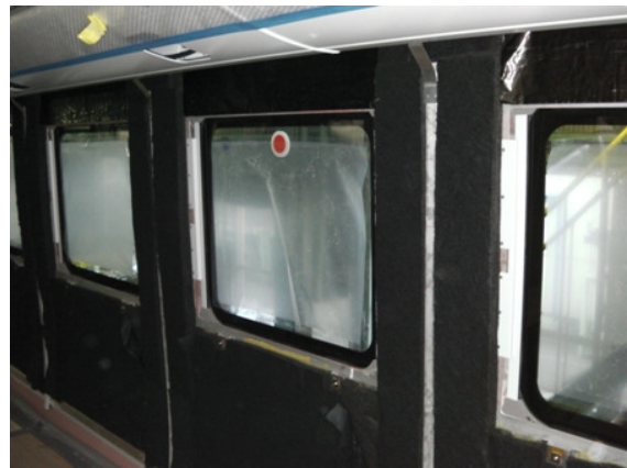
圖8 車內側牆裝隔音材
