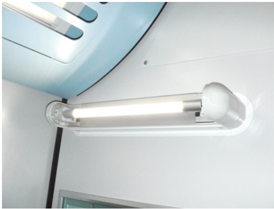
圖95 廁所LED壁燈檢查
