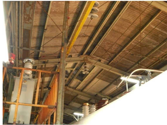
圖90 誘導耐壓試驗送電中
