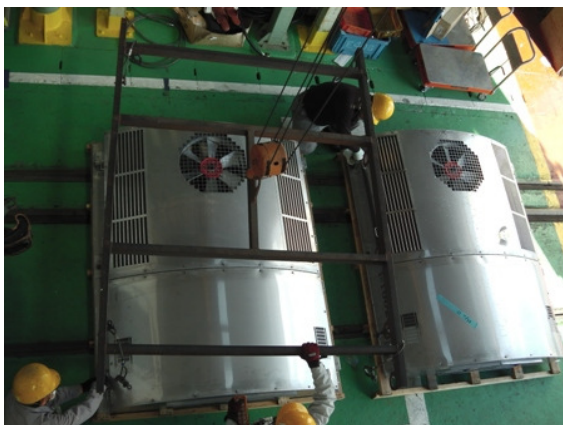
圖3 空調機更換吊掛作業
