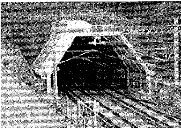
圖 53. 附有導管型的隧道緩衝工程
