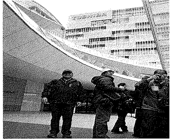
圖 30. 東京川崎之東芝電機總部
