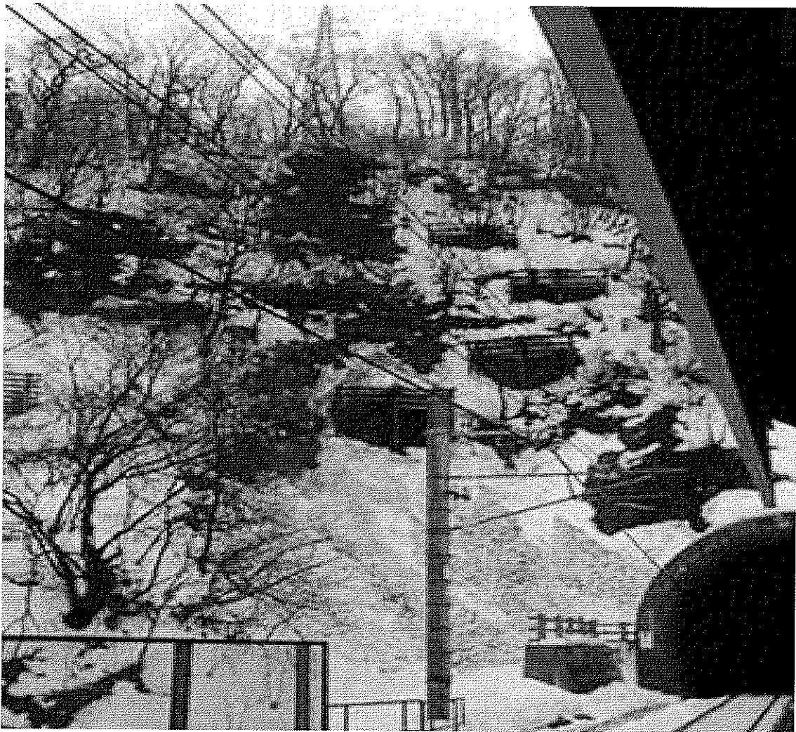
圖 76. 設置於鍋立山隧道大島口的防雪廊 (設於北北線大島站月台)
