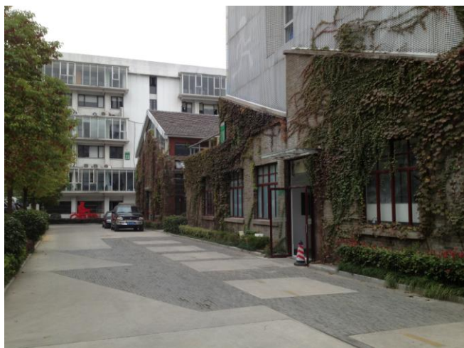
圖 1 創意中央產業園區-立面倒影為鋪面
