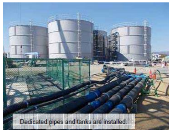
圖 32 繞流排水管及貯槽
