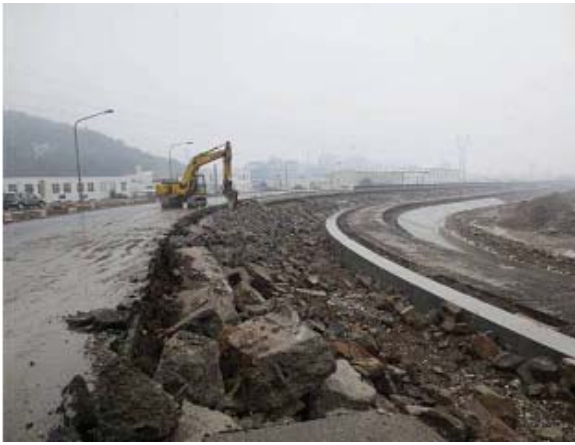
圖 28 舊海堤拆除
