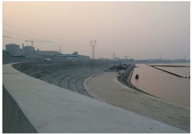
圖 29 新海堤施工情形
