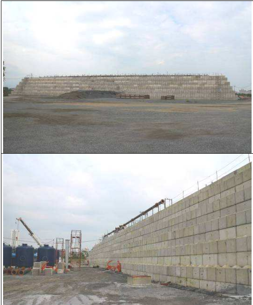
圖 24、峴港機場戴奧辛污染土壤整治設施 IPTD 外觀
