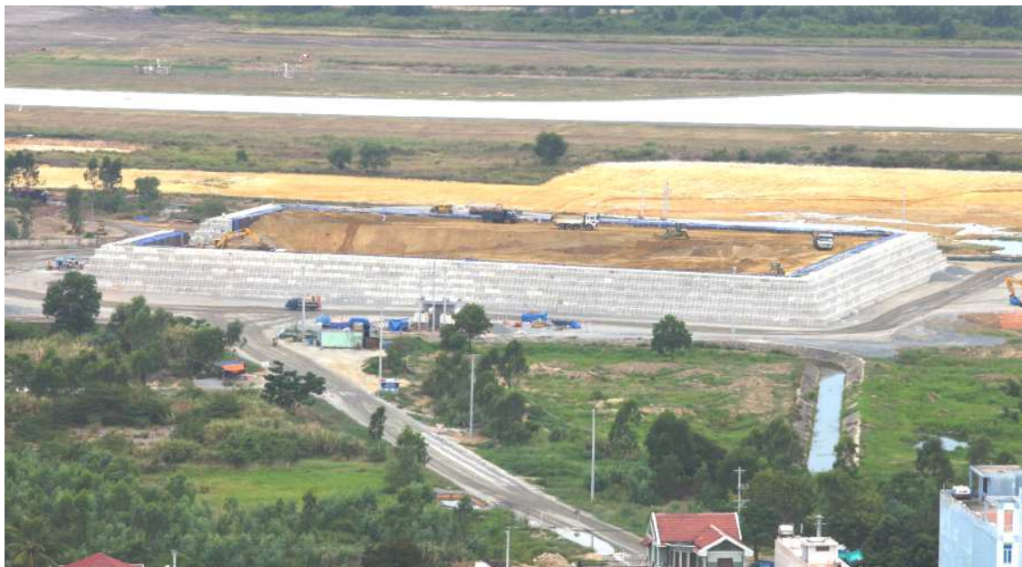
圖 17、IPTD 技術之土壤堆置施工作業情形
