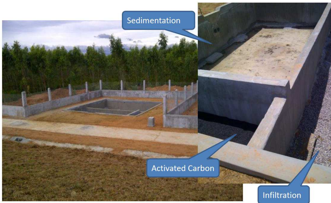
圖 9、富吉(Phu Cat)空軍基地戴奧辛污染土壤掩埋場滲出水處理場
