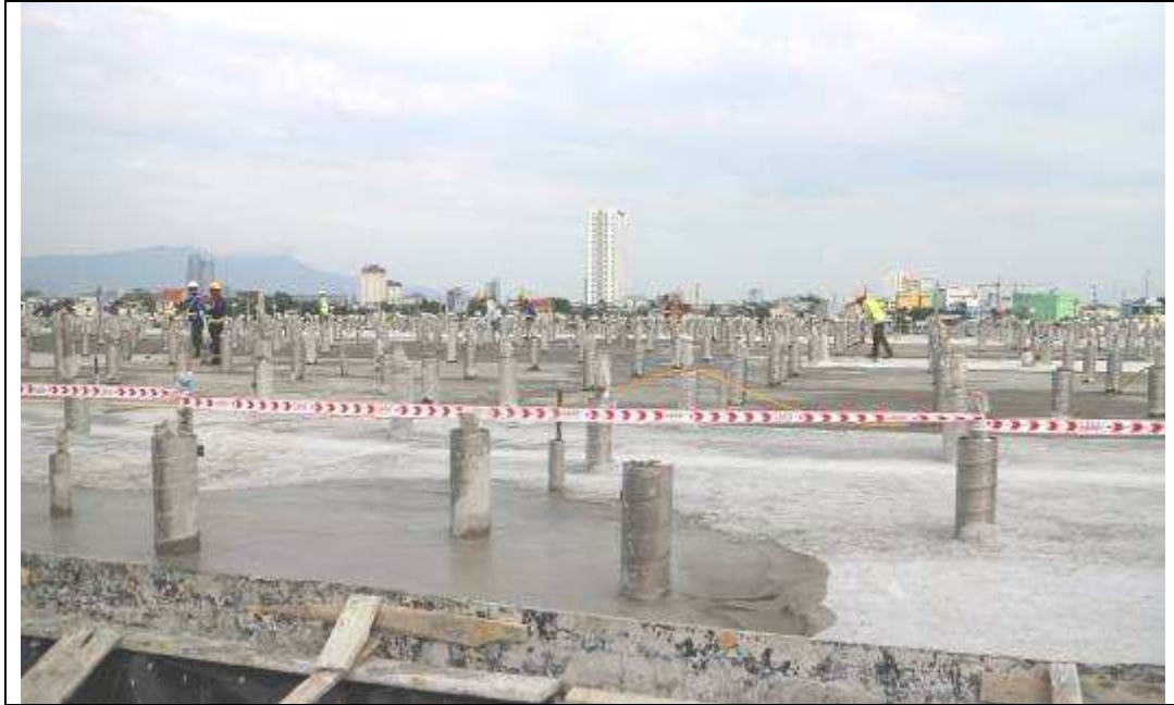
圖 25、峴港機場戴奧辛污染土壤整治設施 IPTD 上部管線施工情形
