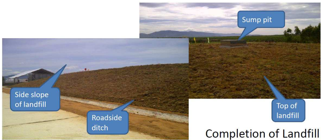
圖 8、富吉(Phu Cat)空軍基地戴奧辛污染土壤掩埋場完成照片
