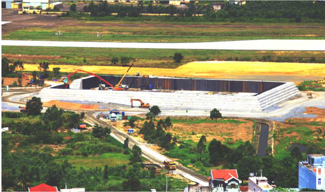
圖 16、IPTD 技術之土壤堆置結構結構體建造情形
