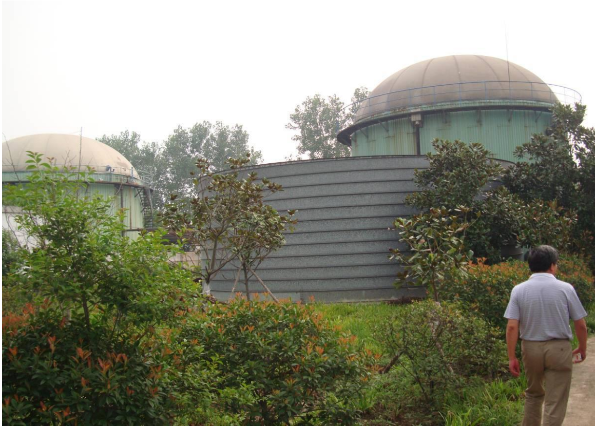
圖 30 一體化厭氧消化槽
