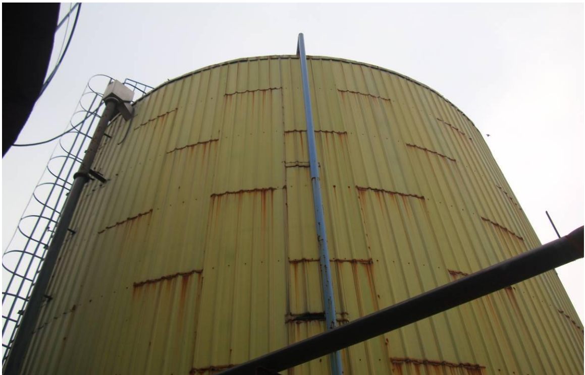
圖 31 厭氧消化槽攪拌機
