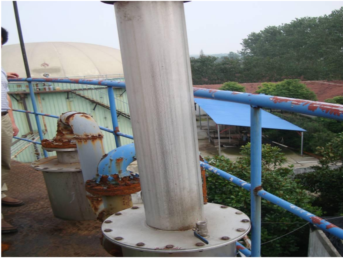
圖 34 厭氧發酵槽頂安全設施
