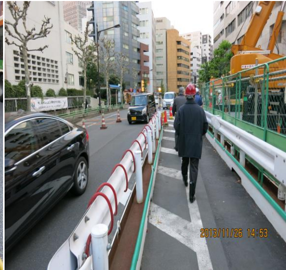
圖 16 工地交管情形(二)
