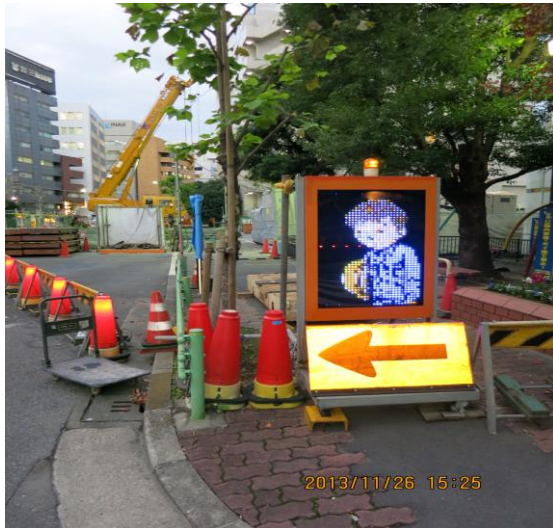
圖 17 工地交管情形(三)
