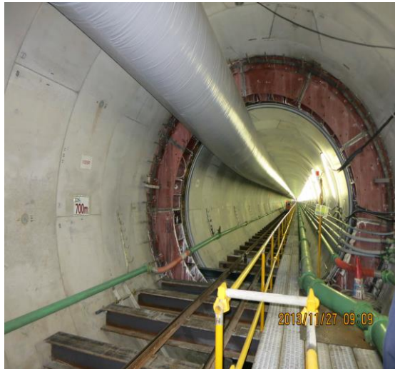
圖 24 不同管徑洞道交接處
