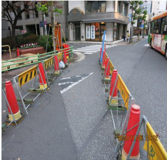
圖 15 工地交管情形(一)
