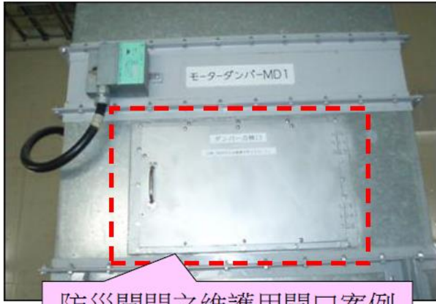
圖 3 運轉控制盤及防災閘門
