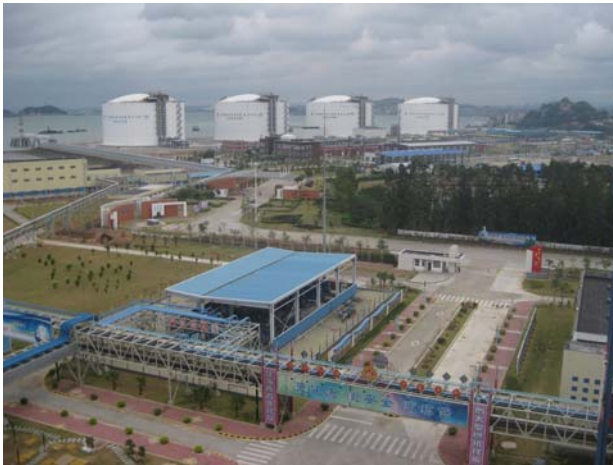
由電廠遠眺福建 LNG 接收站 4 座儲槽
