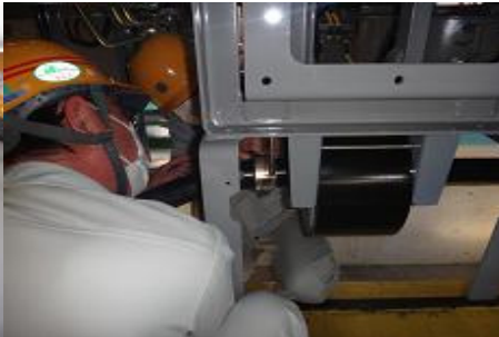
圖18高壓電纜結線
