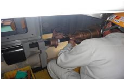
圖17高壓電纜結線
