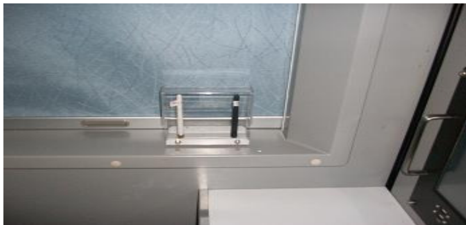
圖48GSM/GPRS系統天線
