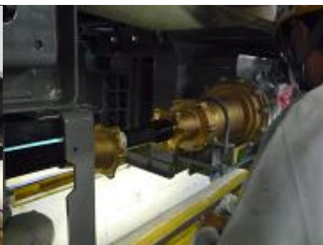
圖20高壓電纜結線
