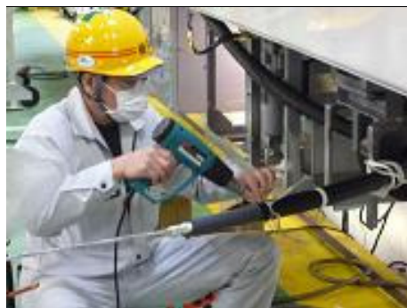
圖19高壓電纜結線
