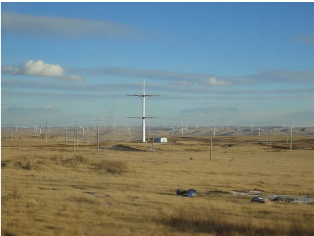
圖 15、只剩骨架之大型垂直軸風機
