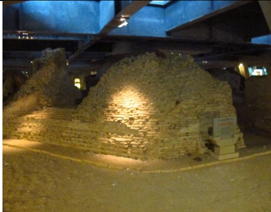
照片 2.3 僅存的原塔磚牆
