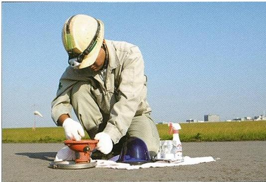
更換故障的燈泡，預防維護方面利用每晚航機起降較少時間（成田機場每天 23 點到早上 6 點場面燈光維護），定期輪流更換拆回部份跑道燈具，供
