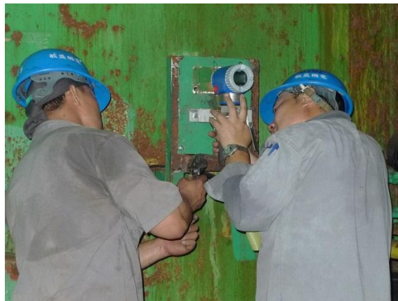
5. 新 DCDAS 設備盤基座定位及固定
