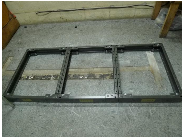
5. 新 DCDAS 設備盤基座定位及固定
