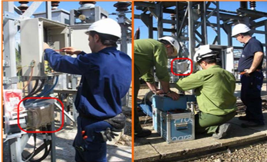
圖 4-8 GE Hard Fiber Process Bus System 裝設於 Benavente
