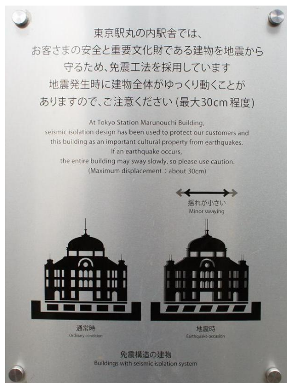
圖 23 丸之內側站房免震構造告示
