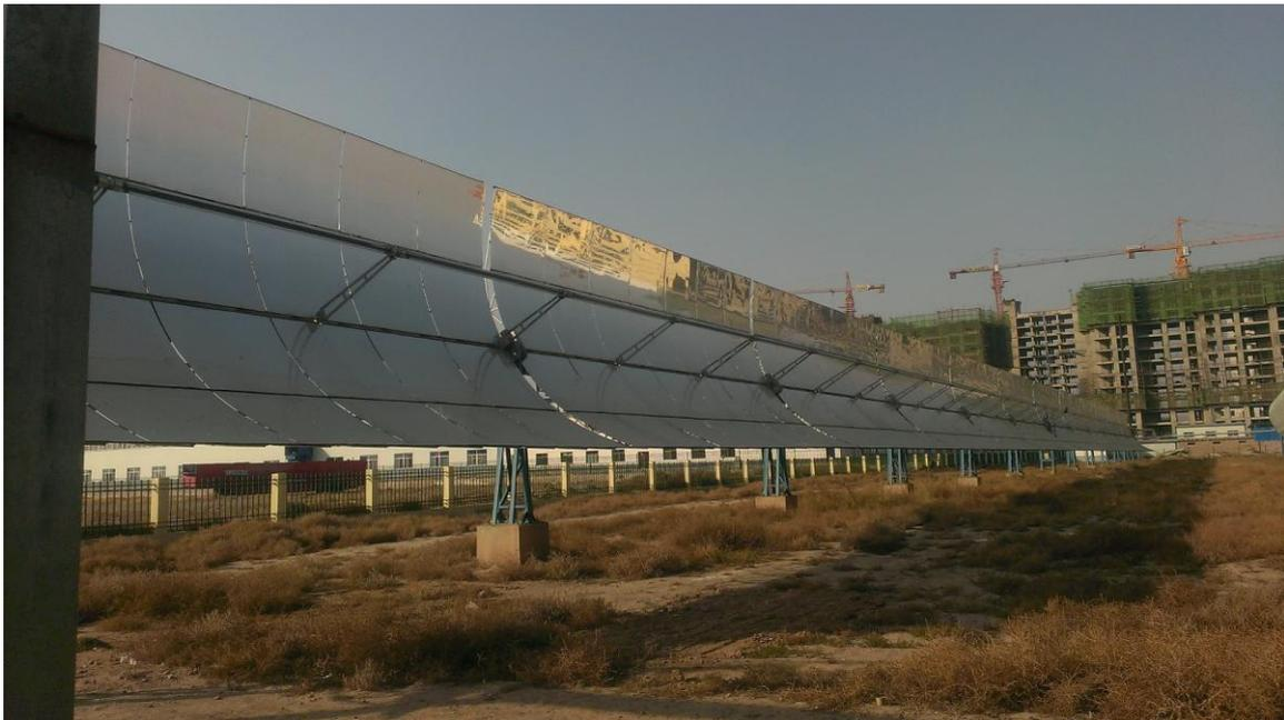
圖 7 840 kWth 槽式聚光太陽熱能示範系統
