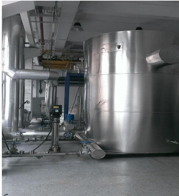
圖 10 熔鹽儲熱系統
