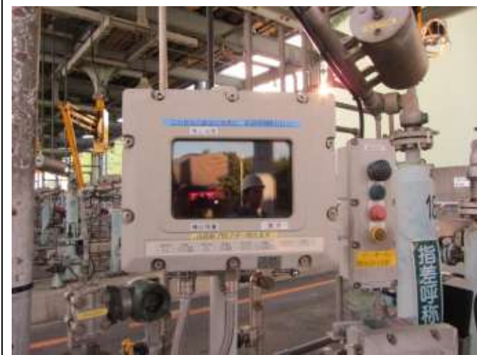
灌裝泵島-灌裝泵島上的自動化設備，可供提貨人員確認產品、數量資訊，並同基地人員共同開始灌裝作業
