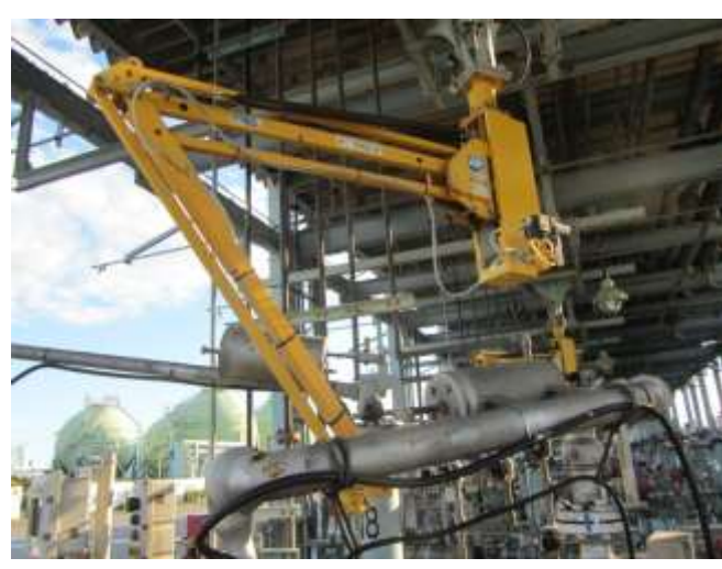
灌裝泵島-液態管及氣態管
