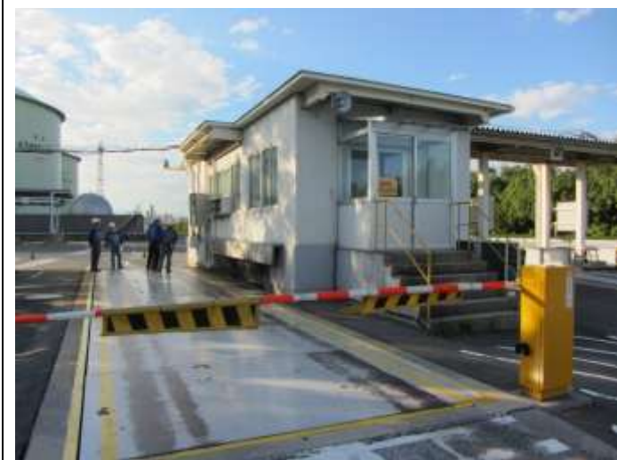
入口處地磅，此基地發貨系統自動化程度非常高，由入口處的過磅開始的入場到後續的灌裝，都已導入資訊設備及系統，作業流程簡化程度很高。
