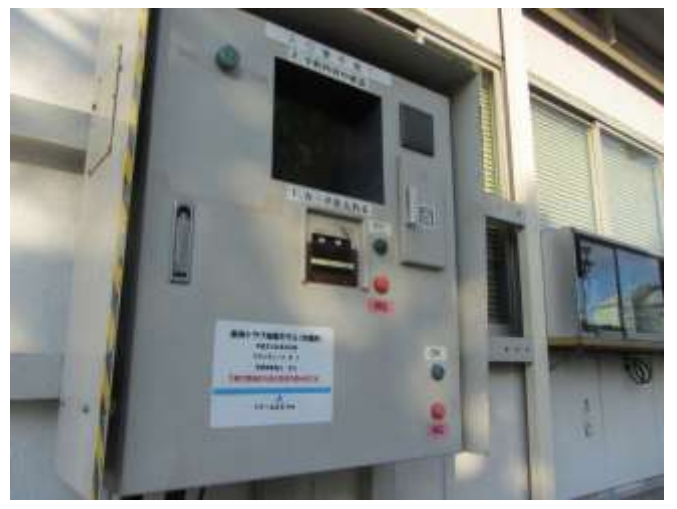
入口處地磅的自動化驗證及操作面板
