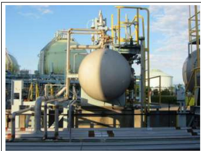
加臭設備 - 以整個 package 方式包覆於圖片中之圓柱體中
