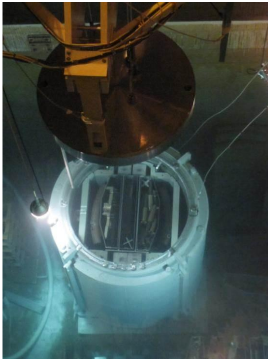
圖四十、西班牙 JOSÉ CABRERA NPP 爐內組件拆解_乾貯容器的內箱封蓋
