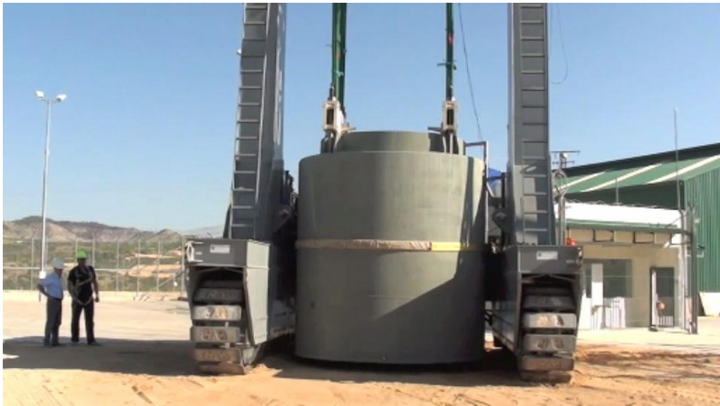
圖四十六、西班牙 JOSÉ CABRERA NPP 爐內組件拆解_乾貯容器運往暫貯廠
