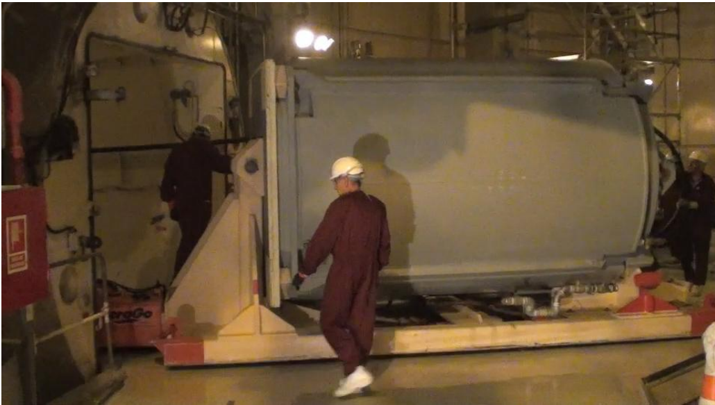
圖四十五、西班牙 JOSÉ CABRERA NPP 爐內組件拆解_乾貯容器的內箱吊運出廠(二)
