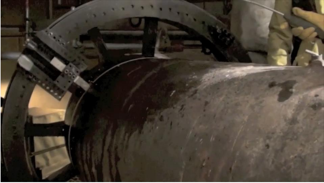
圖五十六、西班牙 JOSÉ CABRERA NPP 除役_NSSS 拆解_大管徑管路切割(三)
