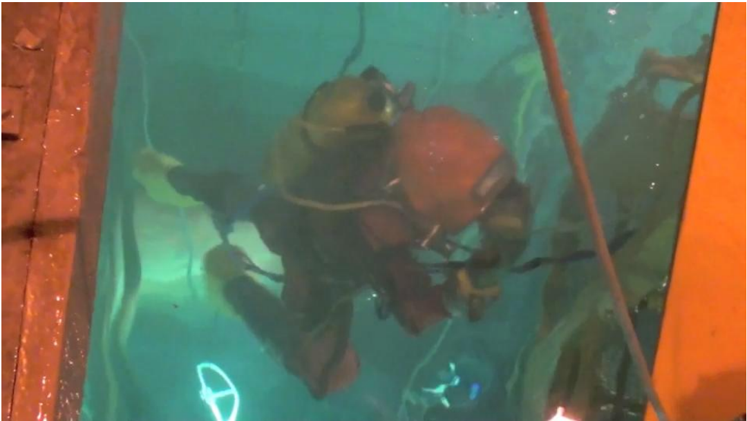
圖三十五、西班牙 JOSÉ CABRERA NPP 爐內組件拆解_人工排除障礙
