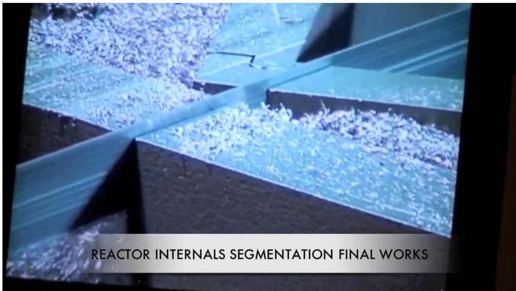
圖三十一、西班牙 JOSÉ CABRERA NPP 爐內組件拆解_鋸切碎削
