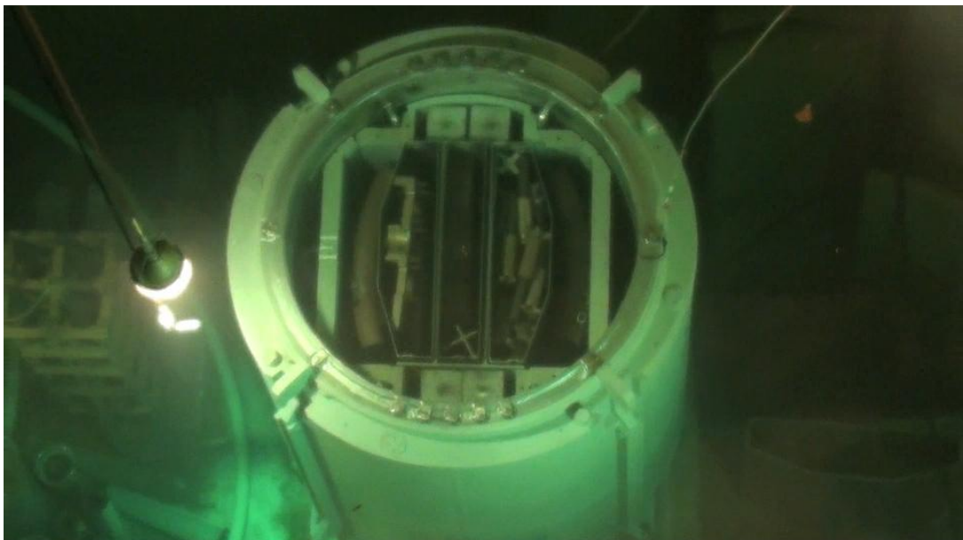
圖三十九、西班牙 JOSÉ CABRERA NPP 爐內組件拆解_乾貯容器的內箱裝載
