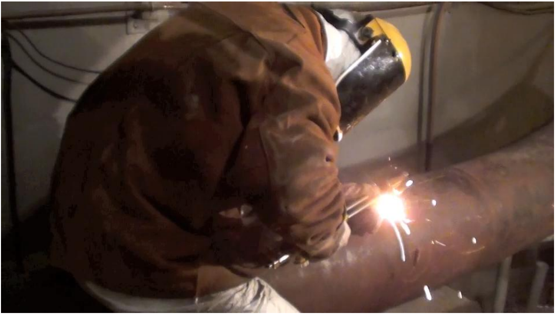
圖五十九、西班牙 JOSÉ CABRERA NPP 除役_NSSS 拆解_熱切割
