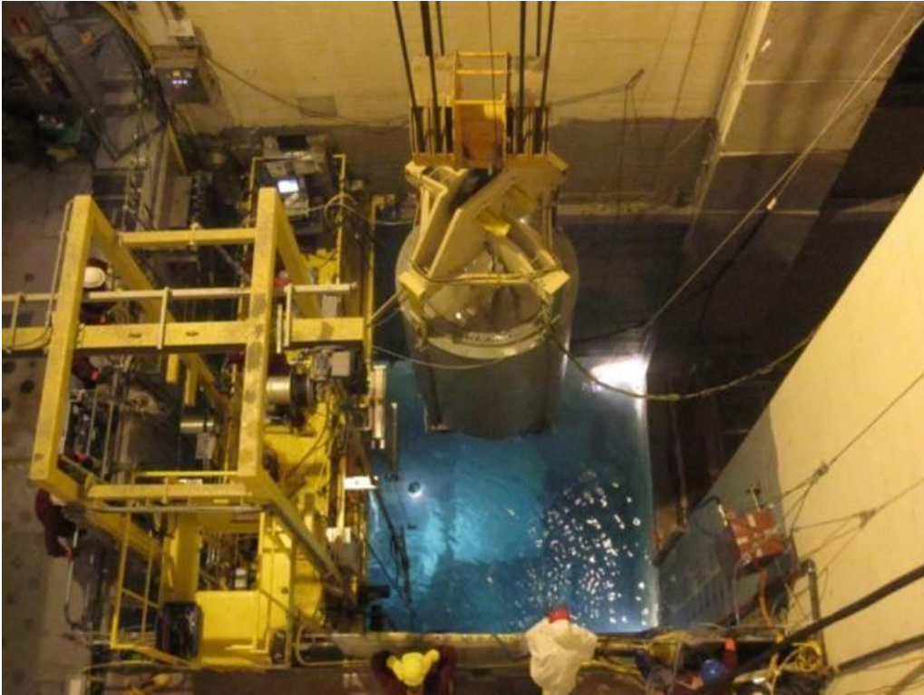
圖四十二、西班牙 JOSÉ CABRERA NPP 爐內組件拆解_乾貯容器的內箱吊出
