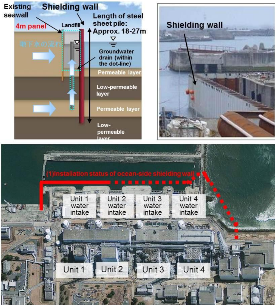
圖十五、Fujushima Daiichi NPS 港區阻隔牆
