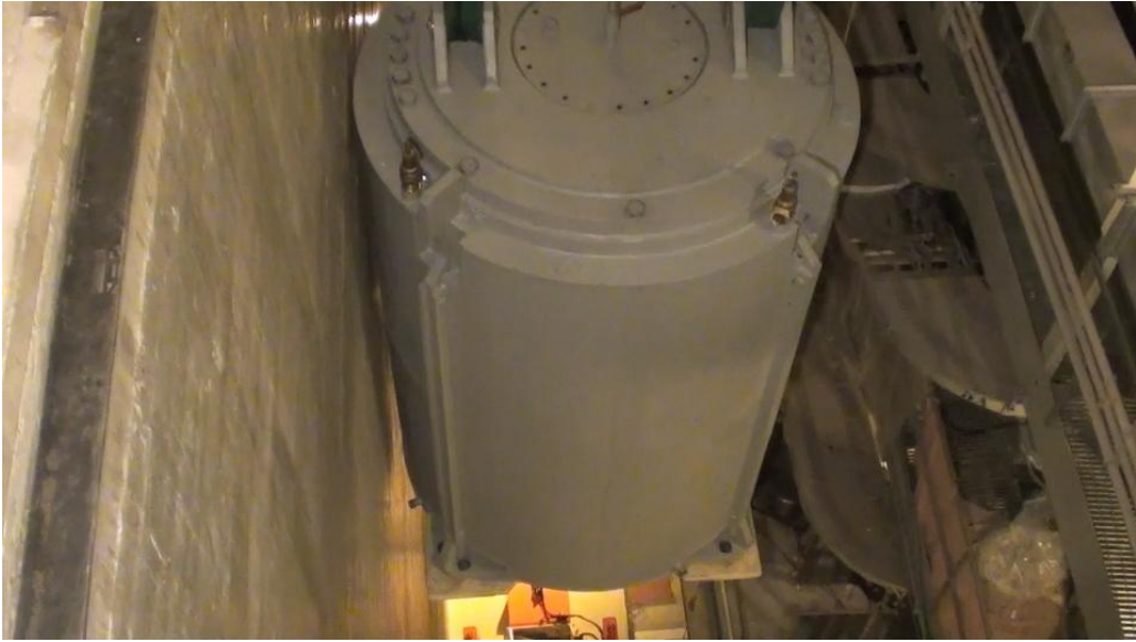
圖四十四、西班牙 JOSÉ CABRERA NPP 爐內組件拆解_乾貯容器的內箱吊運出廠(一)
