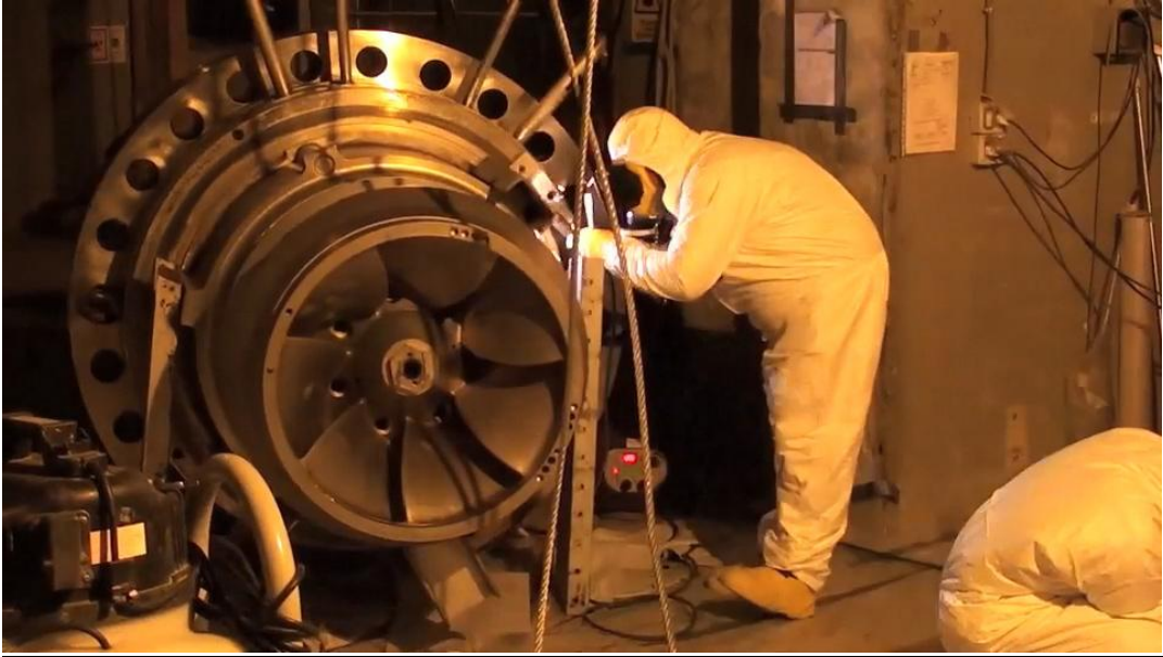
圖五十八、西班牙 JOSÉ CABRERA NPP 除役_NSSS 拆解_大型設備切割
