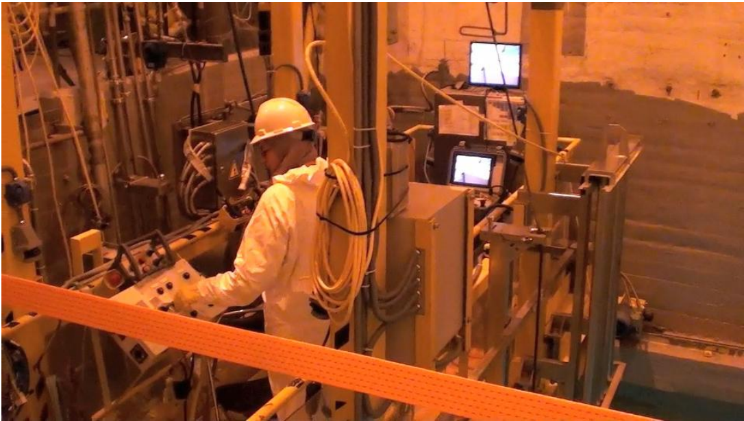
圖三十七、西班牙 JOSÉ CABRERA NPP 爐內組件拆解_水下切割控制系統
