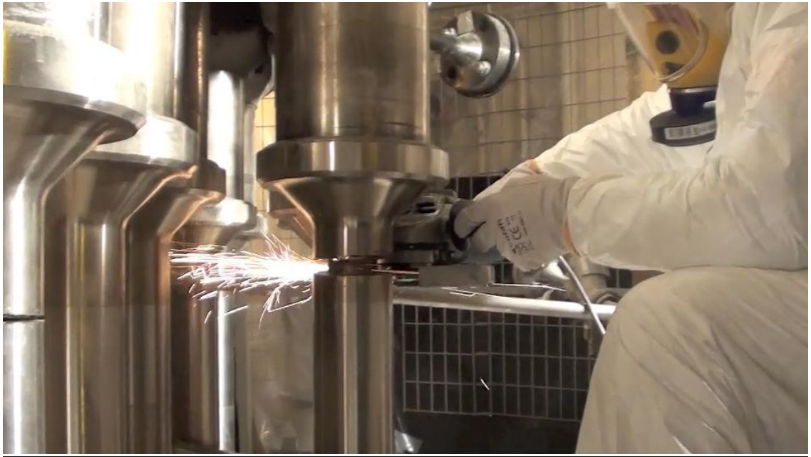
圖六十、西班牙 JOSÉ CABRERA NPP 除役_NSSS 拆解_不鏽鋼設備切割
