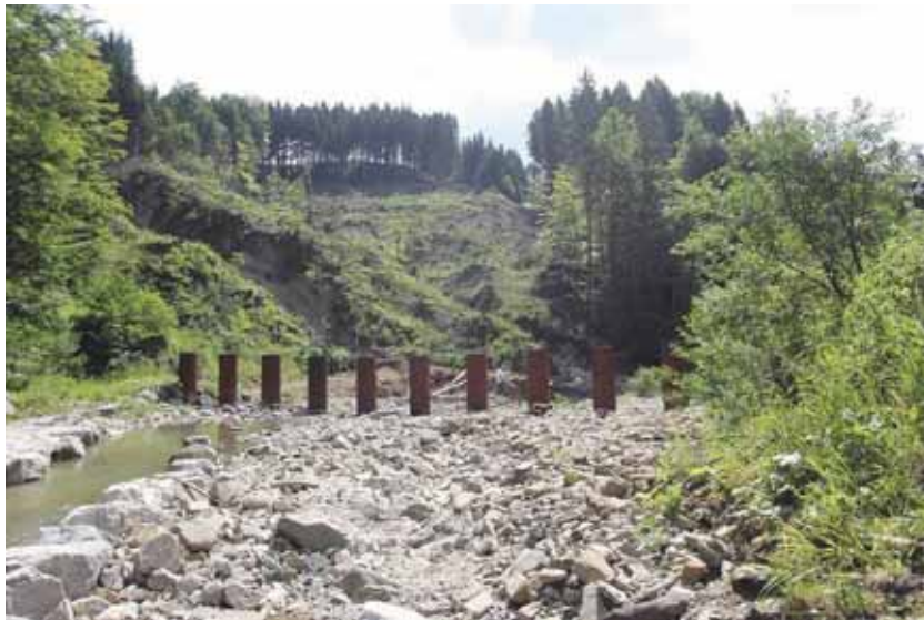
相片 3-25 上游端以梳子壩初步阻攔流木及土石
