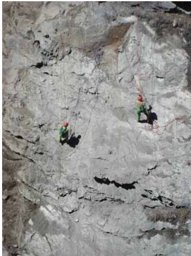
相片3-102 以吊掛方式於陡峭山壁上施工(WLV提供)
