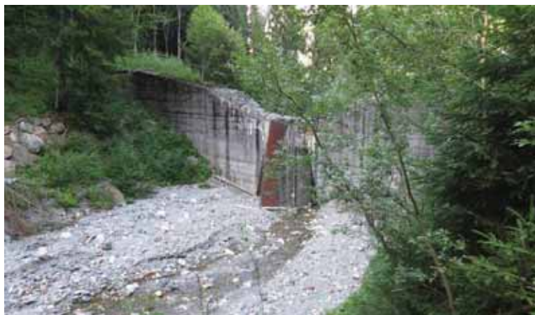
相片 3-49 上游河段適當處設置土砂、流木攔阻壩
