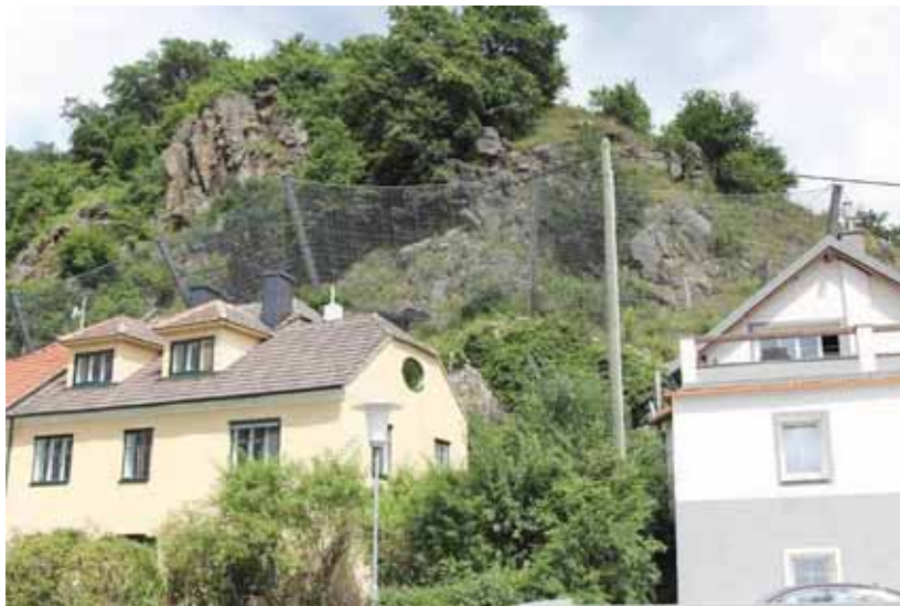
相片 3-19 住宅後方旁的落石防落網(2013.07 攝)
