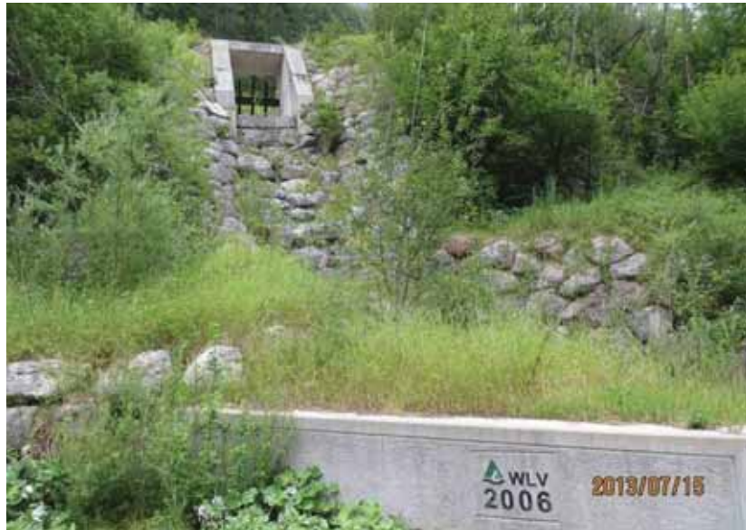
相片 3-35 往哈修塔特(Hallstatt)公路旁的土石流防治工程措施
