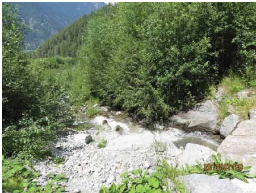
相片 3-88 尋常水位時，水流流經之地下涵管出口。大水時整體河道均為通洪(土石流)斷面
