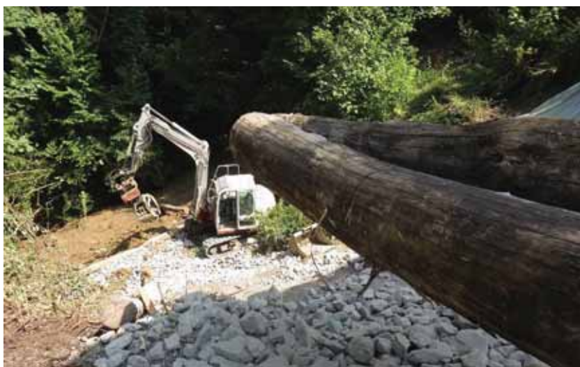
相片 3-60 將枕木直接滑落至邊坡下方
