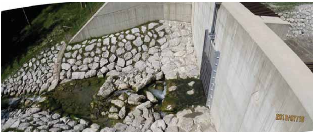
相片 3-52 壩體下游側放水閘門及以塊石鋪排之消能護岸
