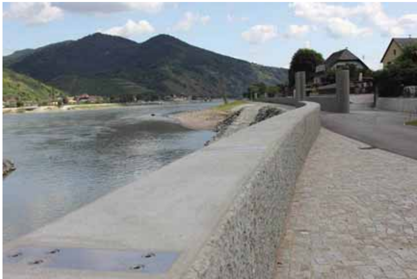
相片 3-16 瓦豪河谷旁的防洪牆基礎設施(2013.07 攝)
