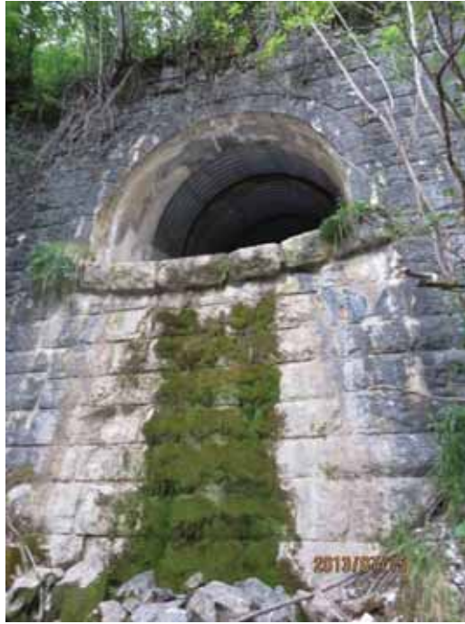
相片 3-40 排水通道之外觀(跌水縱深約 5m，下方有塊石作為消能)
