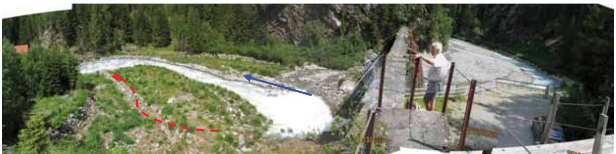
相片 3-93 壩址下游(藍線為常水位流向，紅色虛線為溢流時宣洩路線)
