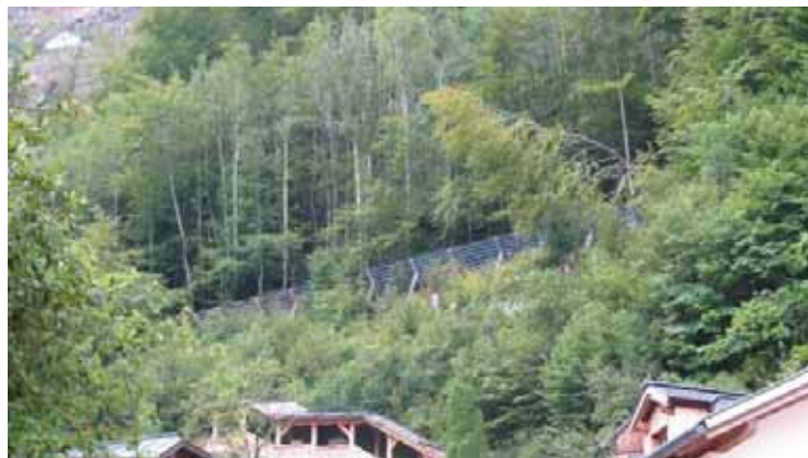
相片 3-45 坡地之防落石裝置與監測計畫(已持續約 30 年)
