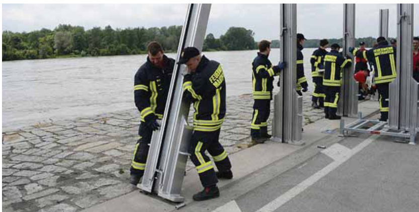
相片 3-14 架設金屬構件情形(Prof. Sevn Fuchs 提供)
