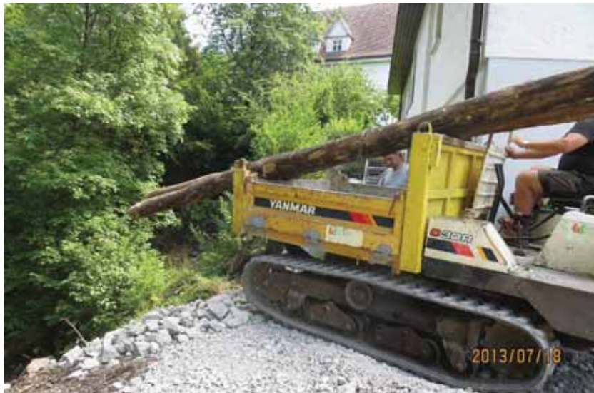
相片 3-59 民宅後方的邊坡整治工程
