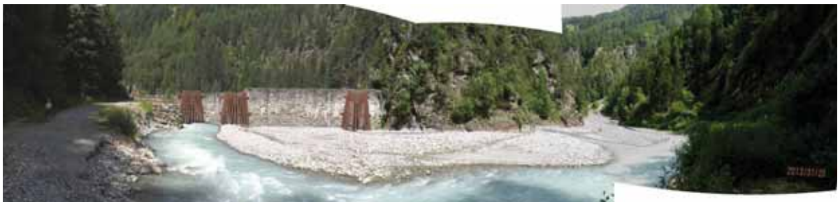
相片 3-92 位於河道彎處之滯洪壩，並有三處洩水閘門
