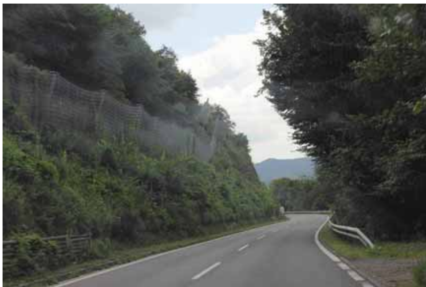
相片 3-18 瓦豪河谷公路旁的落石防落網(2013.07 攝)
