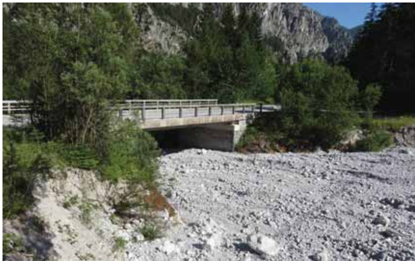
相片 3-53 山區公路旁之土石流潛勢溪流
