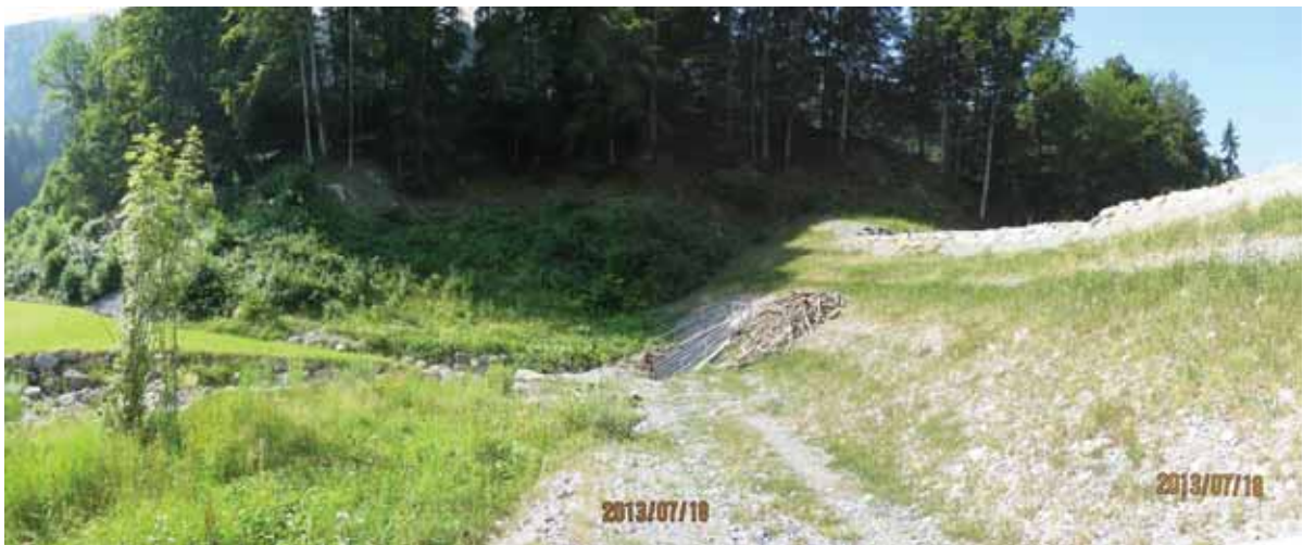
相片 3-69 滯洪池區後方之攔水堰
