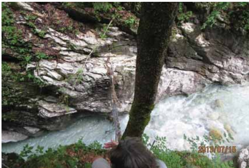
相片 3-34 鋼網施作的土砂及流木攔阻裝置(該懸崖縱深約 20m)
