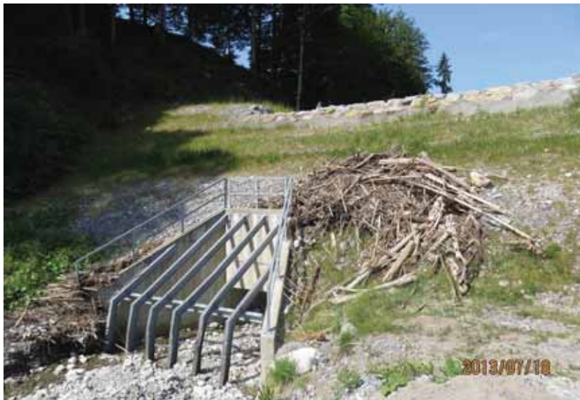
相片 3-70 攔水堰進水口(枯水期水量甚微)
