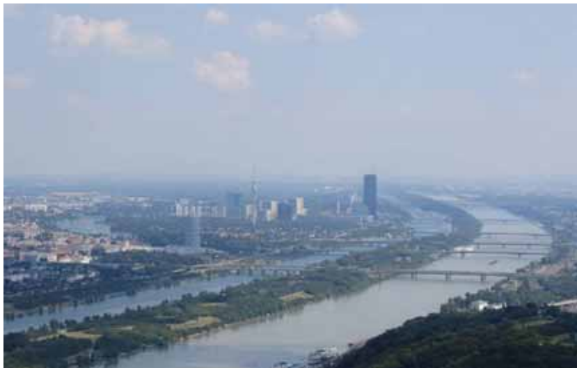
相片 3-5 多瑙河的渠道規劃(右手邊渠道為常水位時使用，洪水時才允許水流走左邊渠道以作為疏洪作用)
