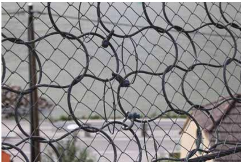
相片 3-20 防落網有減震及消能的設計概念(2013.07 攝)
