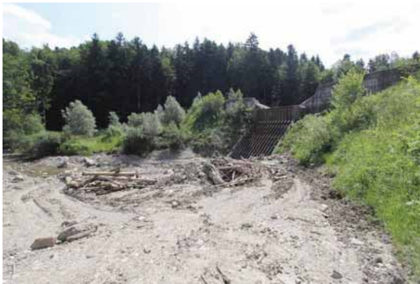
相片 3-27 下游端再以 Dosing Dam 滯洪
