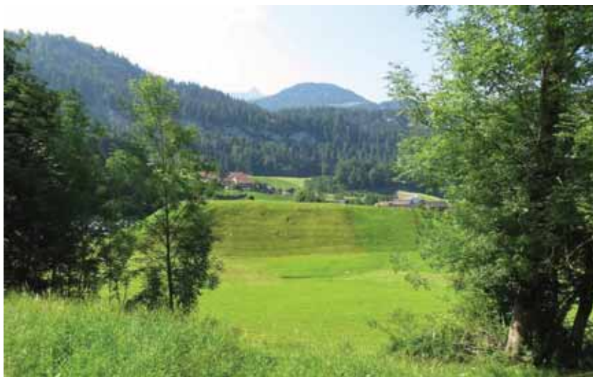
相片 3-66 聚落前可見防雪崩及土砂的土堤構造物
