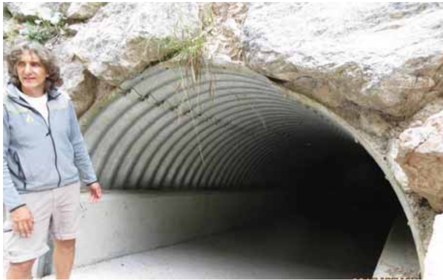
相片 3-38 蓄積土砂的區域旁另設有一條排水通道
