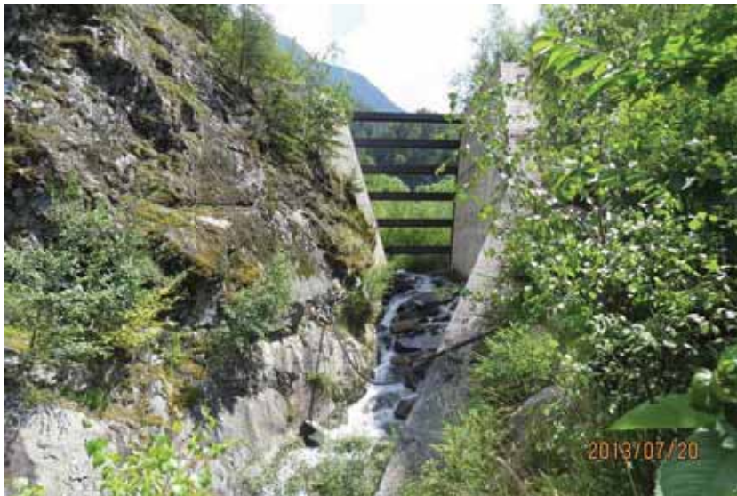
相片 3-89 溪流下游處的攔土石壩(Breaking Dam)
