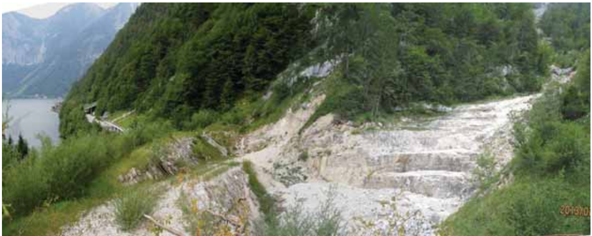
相片 3-37 攔砂壩後方設計為蓄積土砂的區域
