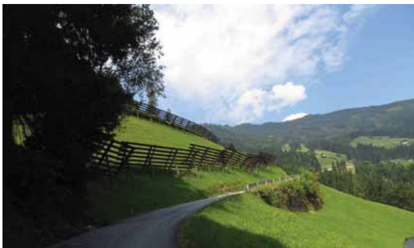
相片 3-75 冬天為雪場因此多有防雪崩落設施
