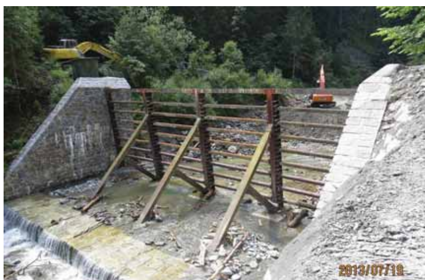
相片 3-73 Breaking Dam 上游清淤中的疏濬工程
