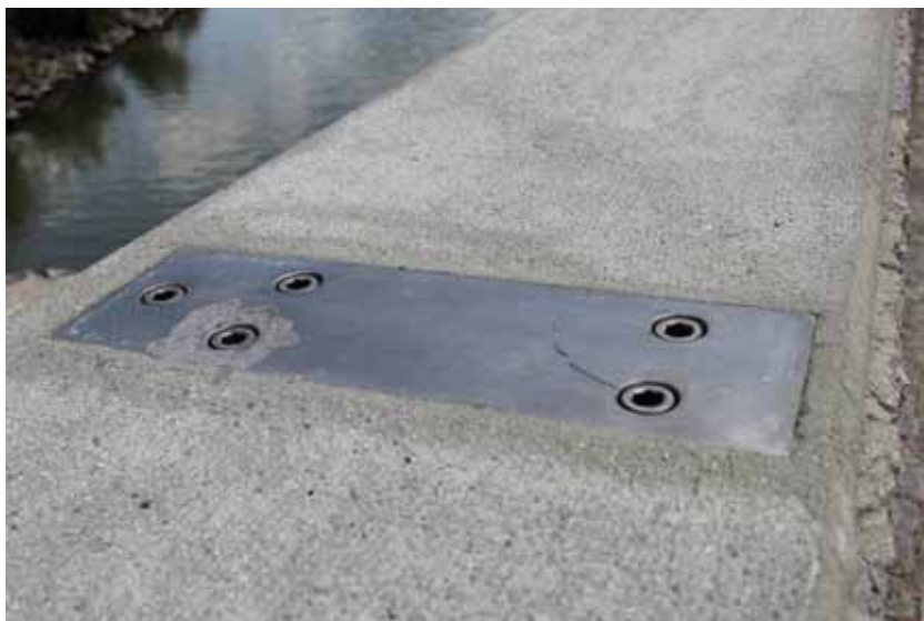
相片 3-17 防洪牆基礎與金屬構件的連結處(2013.07 攝)
