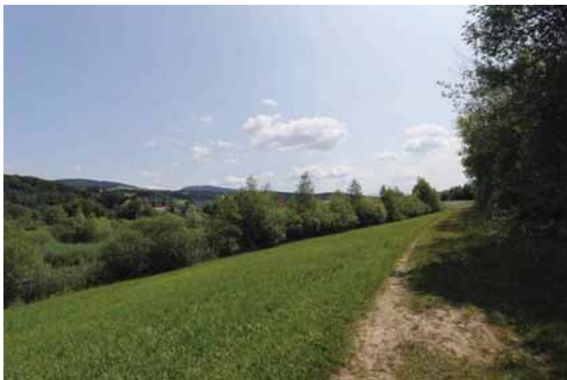
相片 3-30 整體滯洪區域(畫面左側)
