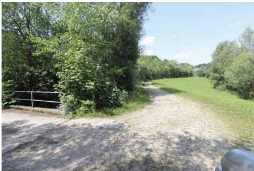
相片 3-28 左側為非汛期的通水渠道，右側為滯洪區
