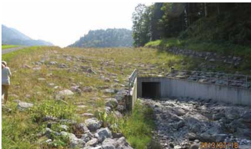
相片 3-72 攔水堰出水口
