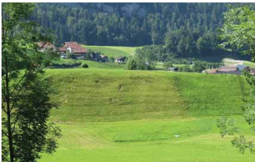
相片 3-67 生態且與環境融合的土堤構造物
