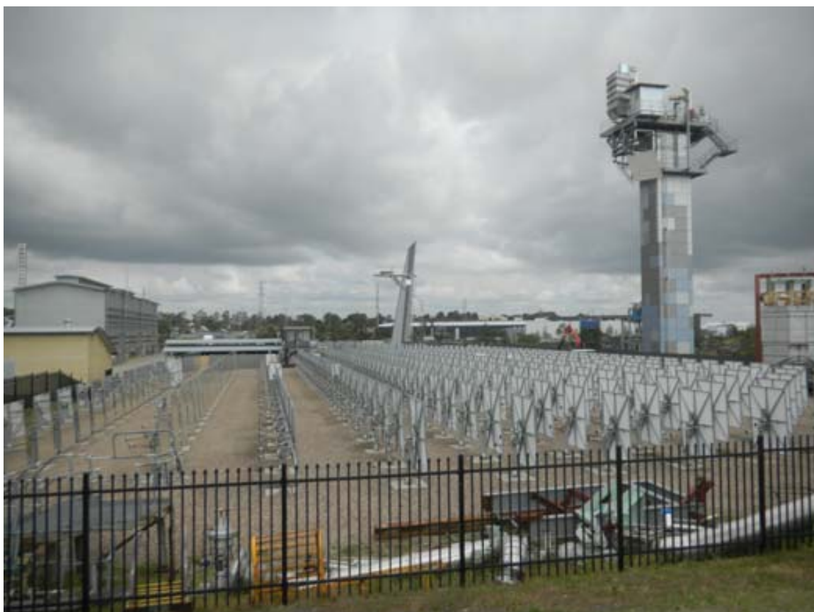
照片 3 澳洲聯邦科學與工業研究組織太陽能發展中心之集熱式太陽能發電試驗設施 塔中有融鹽可熱儲達15小時
