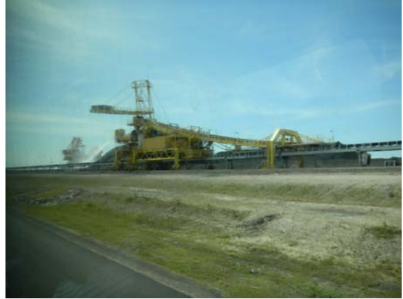
照片 12 Kooragang 儲運站來自獵人谷煤礦堆儲煤炭灑水抑制粉塵作業
