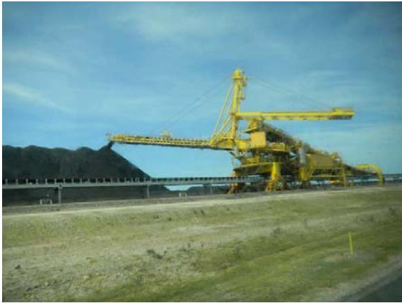
照片 11 Kooragang 儲運站來自獵人谷煤礦堆之煤炭儲作業
