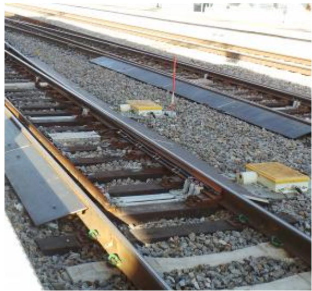
圖 65 用 2 具電動轉轍器推動 1 組道岔
