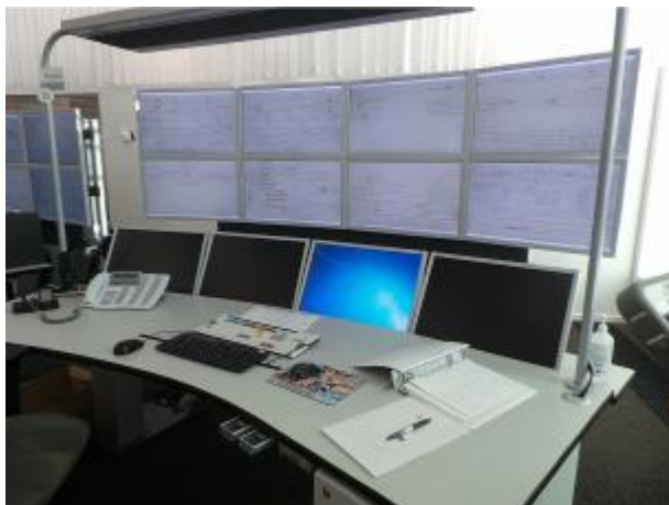
圖 52 斯德歌爾摩中央車站的 OCC 採用小顯示器陣列
