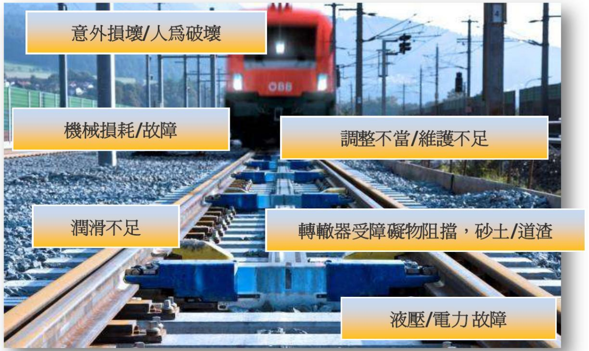
圖 73、電動轉轍器監視效益 (資料來源:CDSRail 簡報)
