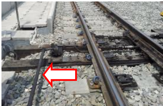
圖 25、本局電動轉轍器輔助拉桿
