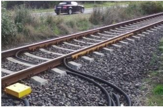
圖 18 輪軸輪緣幾何缺陷偵測單元被安裝鋼軌
