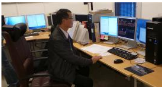
圖 48、號誌系統監控室
