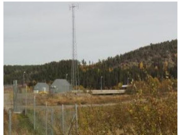
圖 57 Level-2 的 GSM-R 無線電基地台
