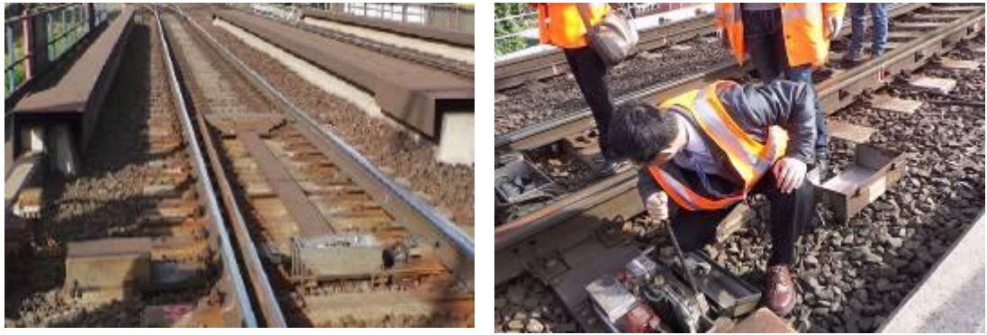
圖 24 Grevenberg-Koln 站場軌道路線，實際觀察油壓式電動轉轍器運作
