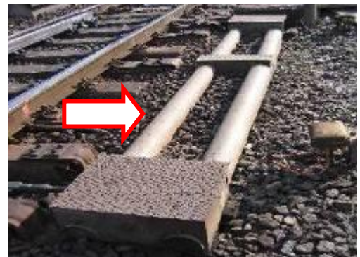
圖 26、德國電動轉轍器輔助拉桿護具
