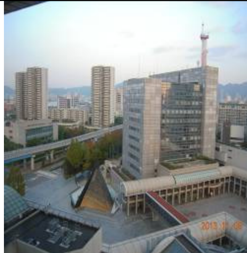
空橋連接飯店、展場、會議中心及捷運站
