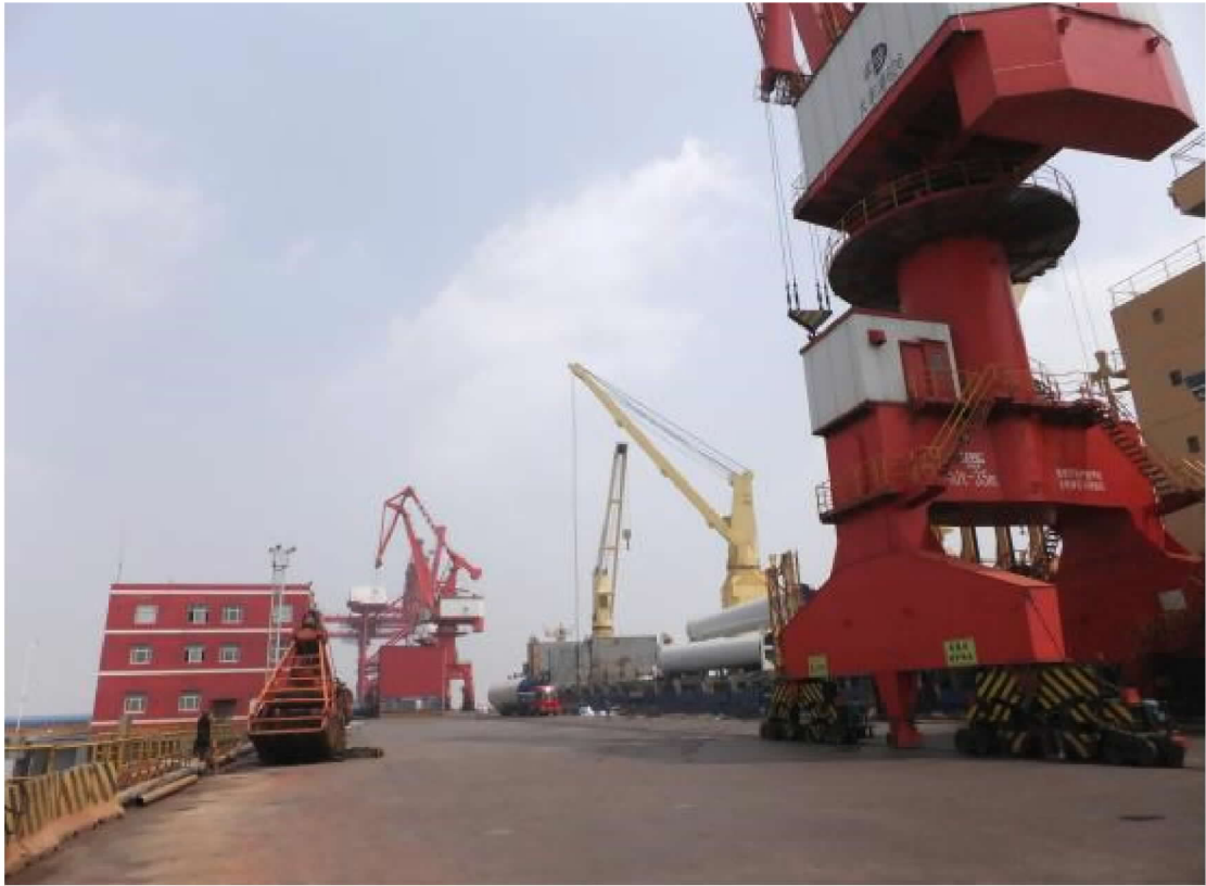
圖 10：風力發電機組件於碼頭現場裝卸狀況。
