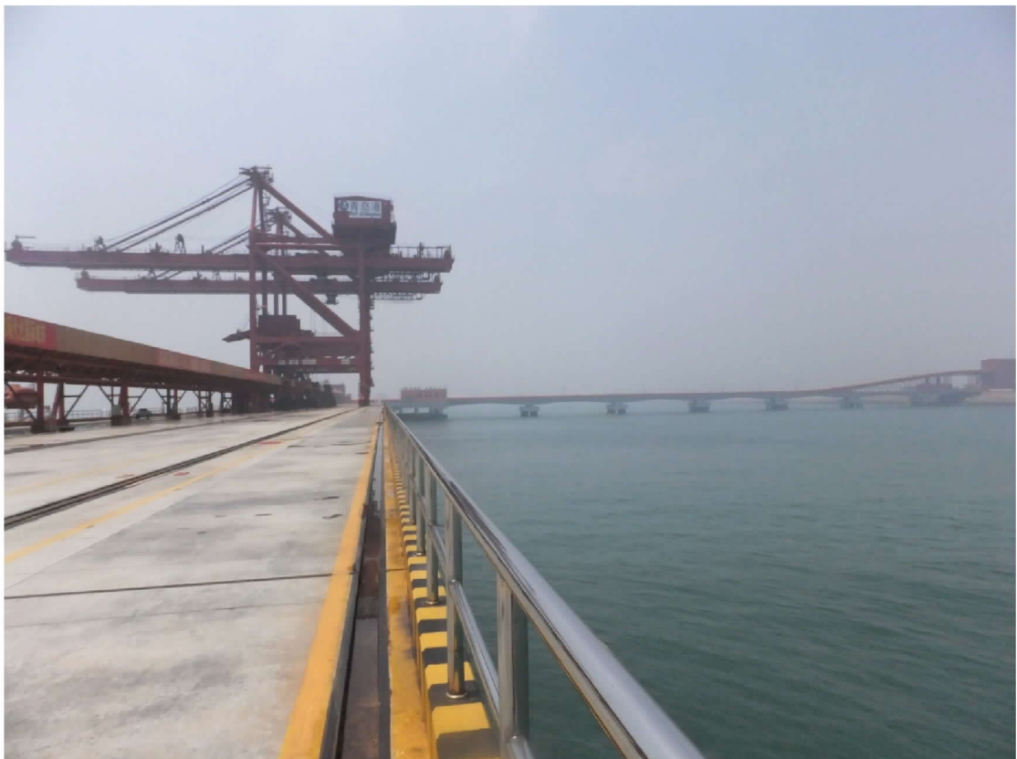
圖 29：礦石碼頭密閉式輸送帶設施。
