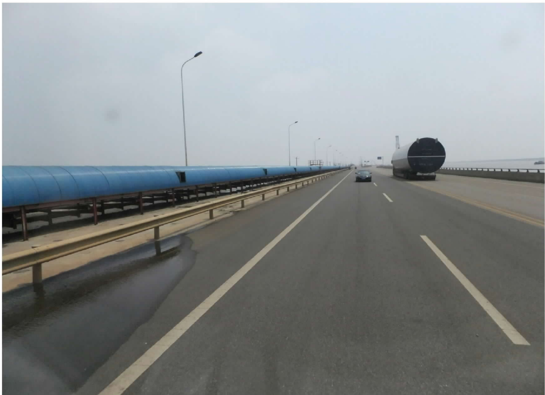
圖 11：左側藍色管路為大豐港由碼頭至後線堆置場，長達 4,000 公尺之密閉式輸送帶，以變頻馬達驅動。
