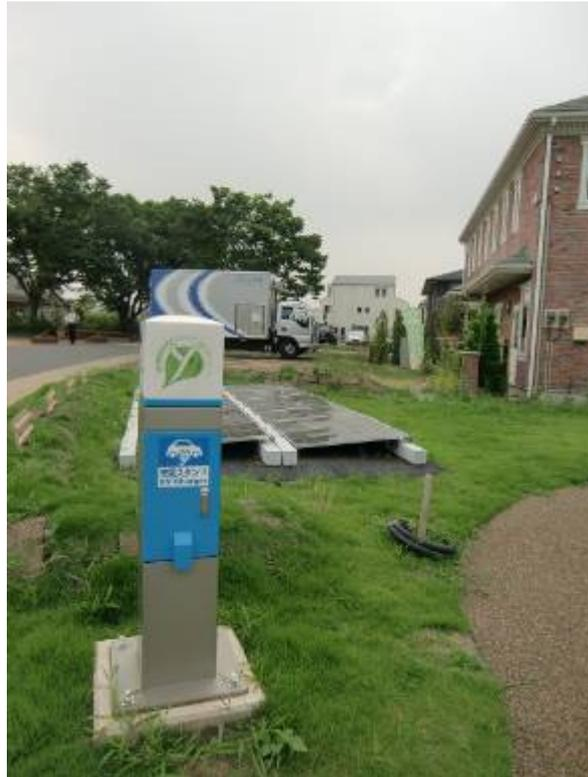
圖23 室外電動車充電器及太陽能板
