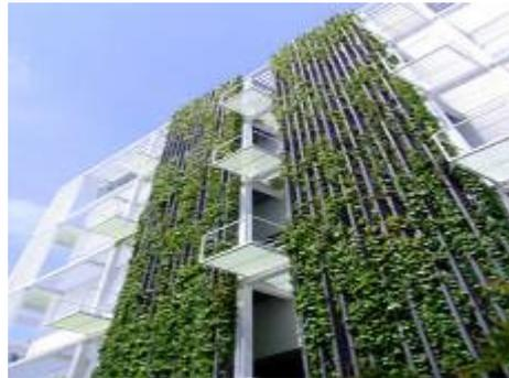
圖 52 竹中技術研究所的垂直百葉窗型牆面綠化系統
