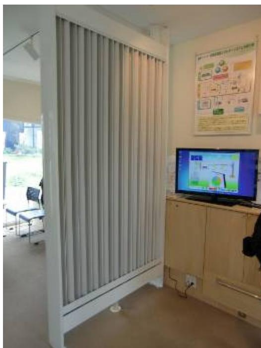
圖16 輻射式冷暖氣設備
