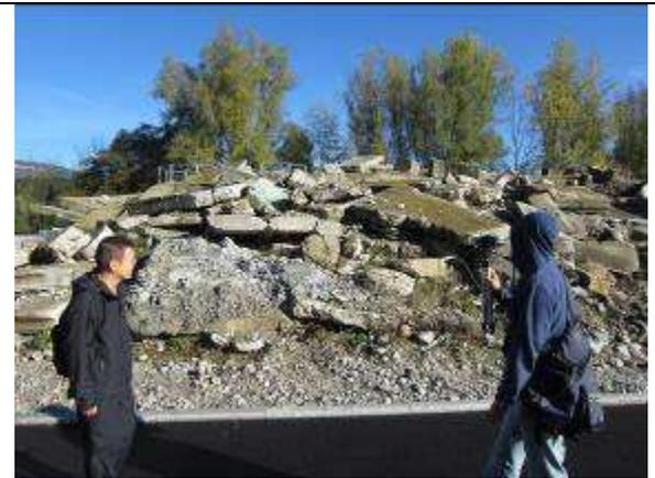
圖 24-1 倒塌建築物訓練場正面(係將完整建築物爆破後建立通道，強化支撐而成之訓練場)。
