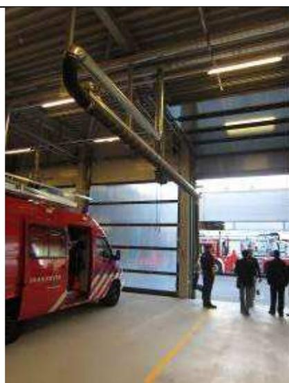
圖 37-8 廢氣排氣管系統設置情形。
