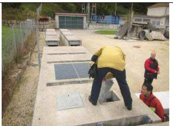
圖 8-4 狹小空間救援訓練設施上端，可打開鐵窗觀看內部情形，並放置檔板作障礙。
