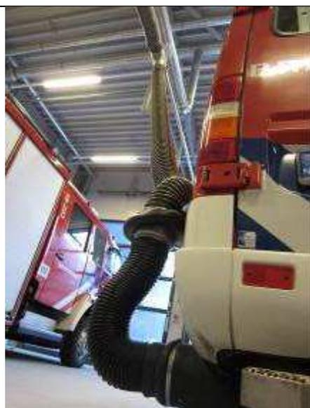
圖 37-6 廢氣排氣管，可引導車庫內之車輛廢氣至戶外。
