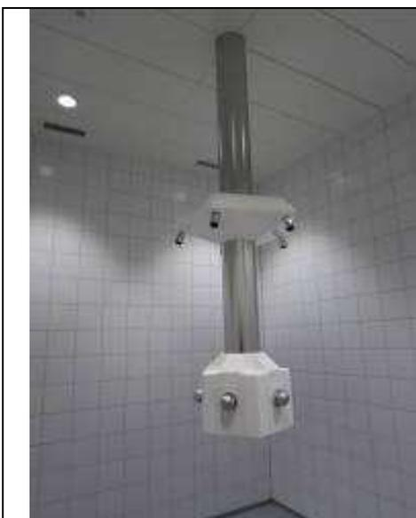
圖 6 淋浴間，按壓下方按鈕上方水管就會出水一段時間，可樽節水資源。
