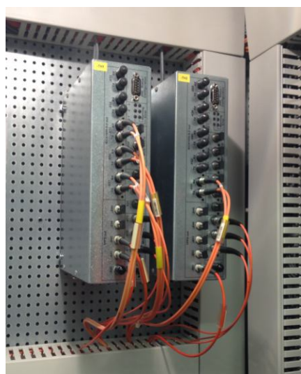
圖 19、Laufenburg 變電所使用之 MU
