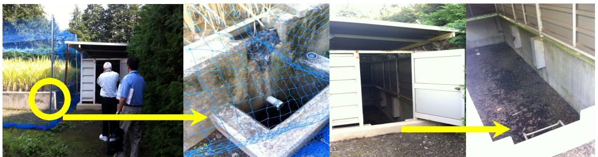
圖 8. 水稻栽植槽之排放水設施及其旁配置之沉積(澱)池
