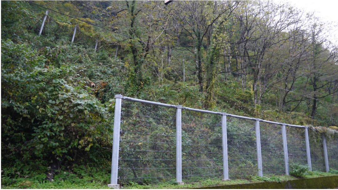
圖 4 柔性防護網（Easy Net 工法，圖左上） 搭配柔性防護柵（High Power Earth Fence 工法，圖右下）
