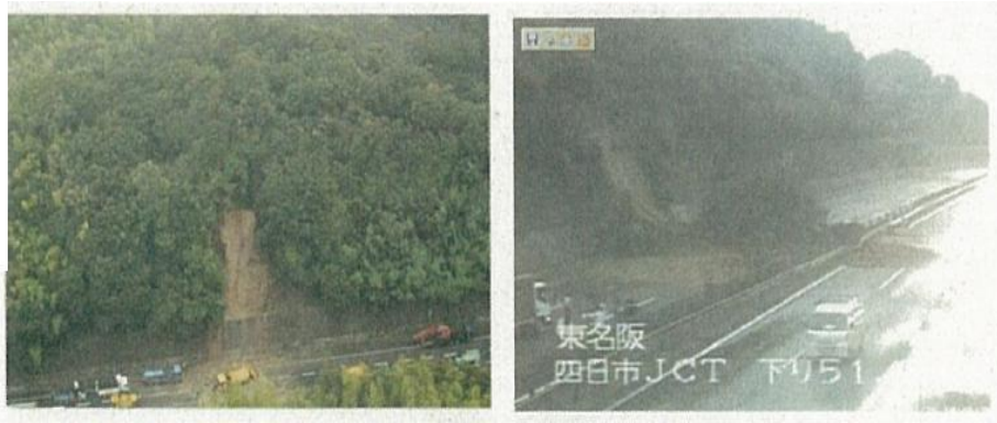
(b) 土砂崩壞情形
