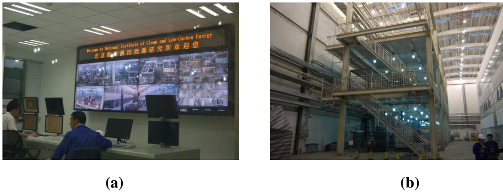
圖 3-21. 煤炭氣化示範廠: (a)監控中心，(b)廠房概況
