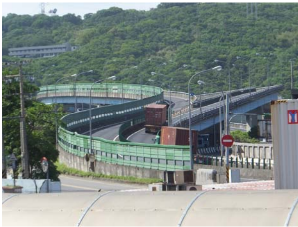
圖 21 陽明海運基隆貨櫃場旁聯外道路
