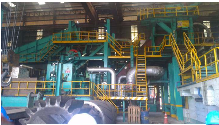
甘蔗壓榨廠房
