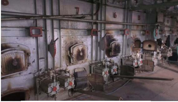
蔗渣發電廠鍋爐
