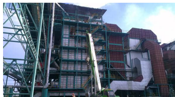
蔗渣發電廠外觀
