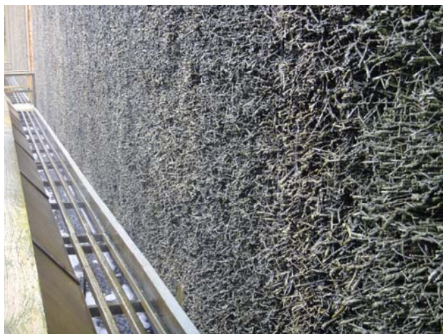
自然生態循環公共裝置 Gradierbau
