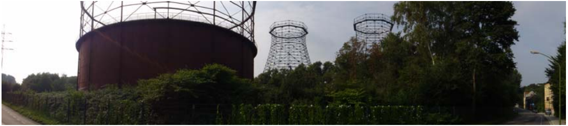
魯爾 12 號礦區舊廠房一景(二)
