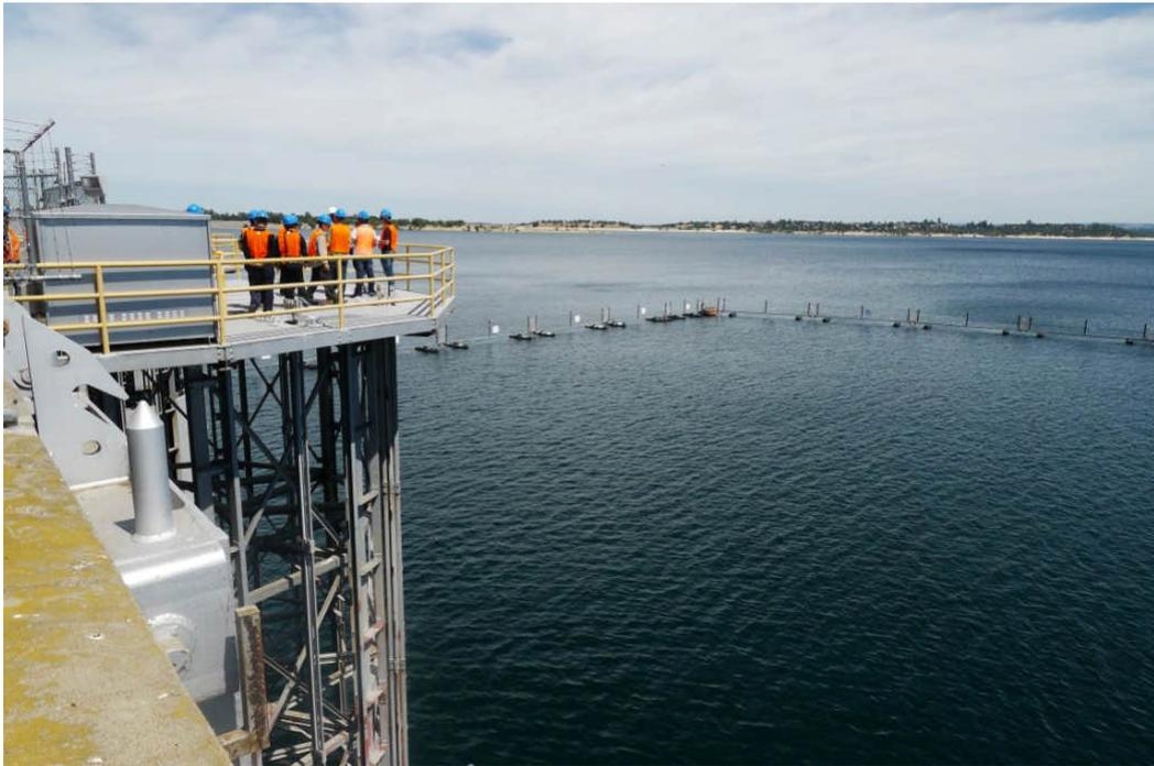
進水口前方水面設置護欄避免浮木或船舶靠近
