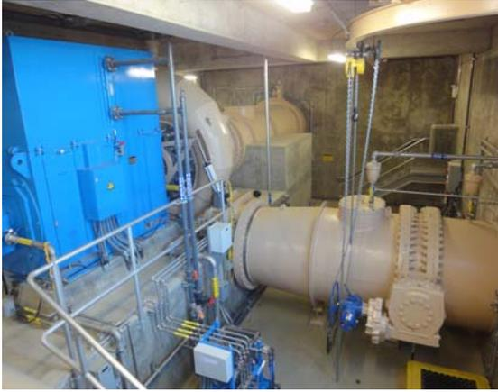
圖 3.4-11 LV hydro 水力發電設備
