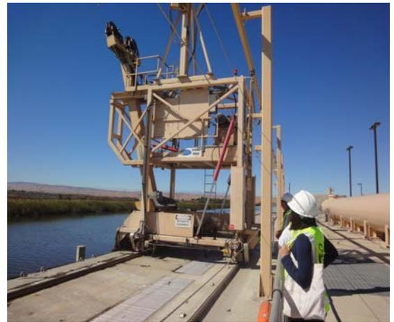
圖 3.4-8 自動清除取水口雜物設備
