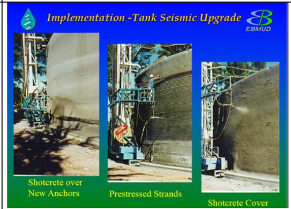
圖 3.5-5 儲水槽用鋼絞線與噴凝土強化[5]
