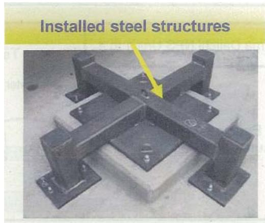
圖七：廠房間管道封板以鋼構補強
