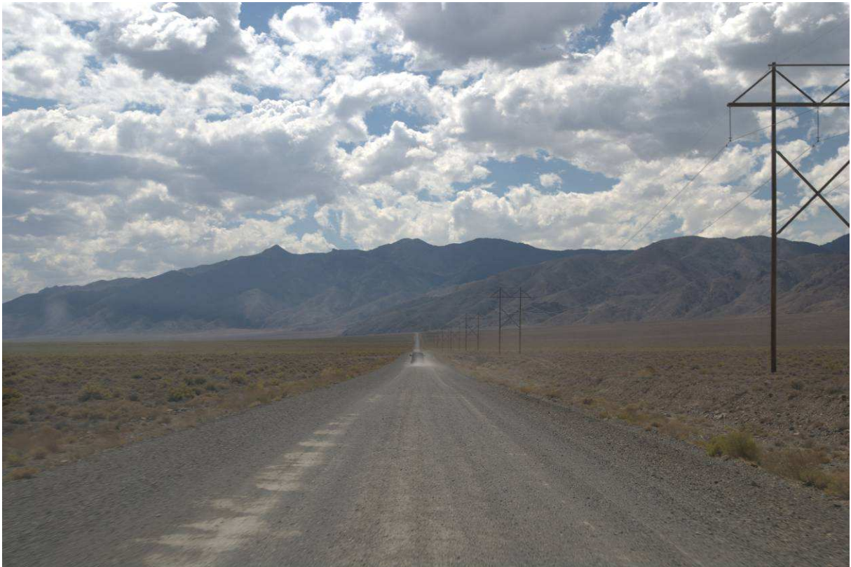
圖22：Dixie Valley地熱電廠對外道路及架空電源線
