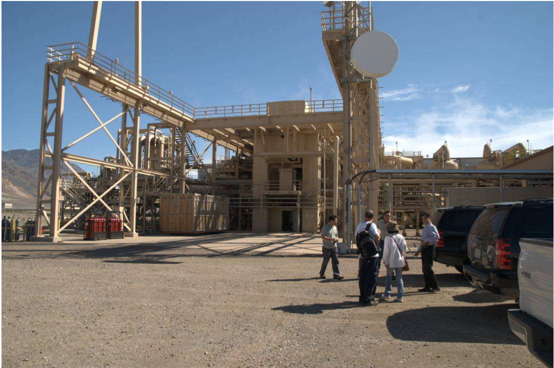
圖15：Dixie Valley地熱電廠60MW閃發式蒸汽發電機組
