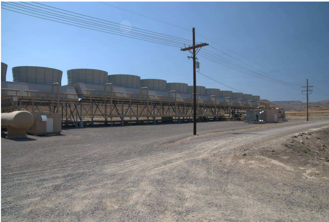
圖 6 : Neal Hto Spring 地熱發電廠之乾式空氣冷卻塔
