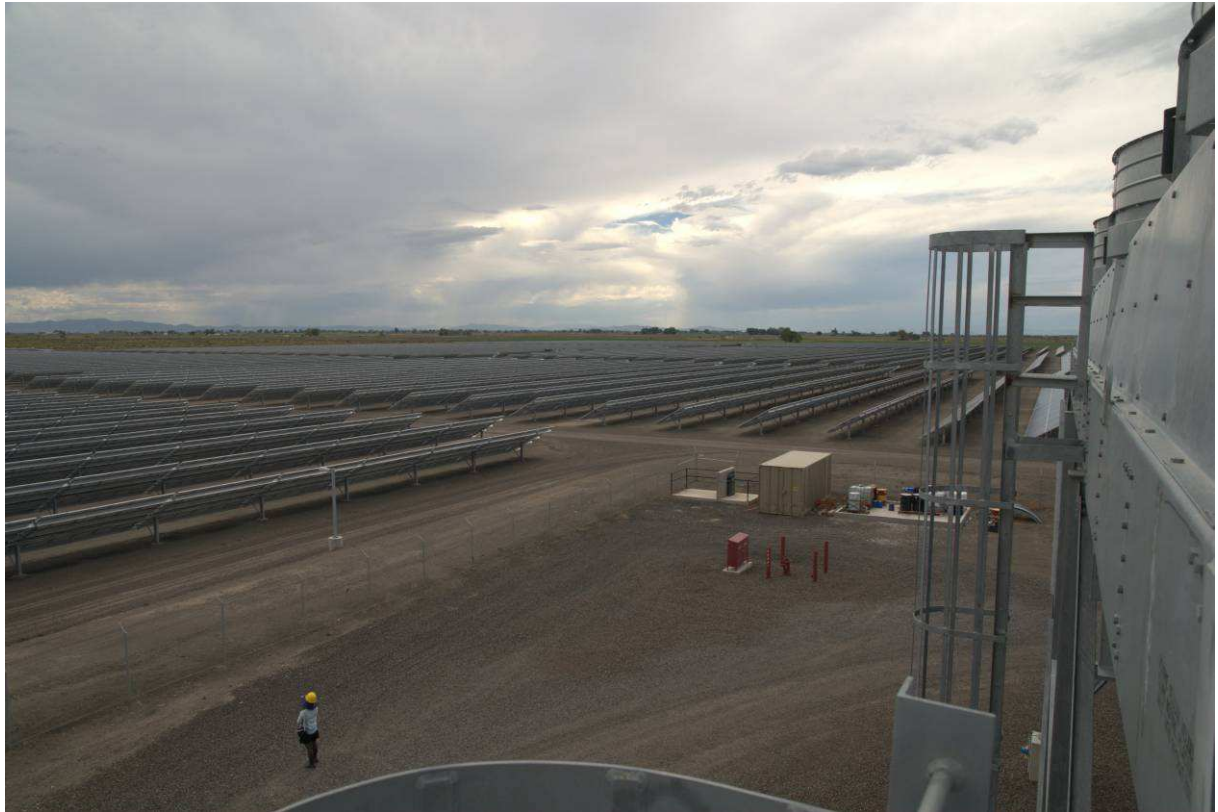
圖12：Stillwater 混合式電廠之太陽光電板
