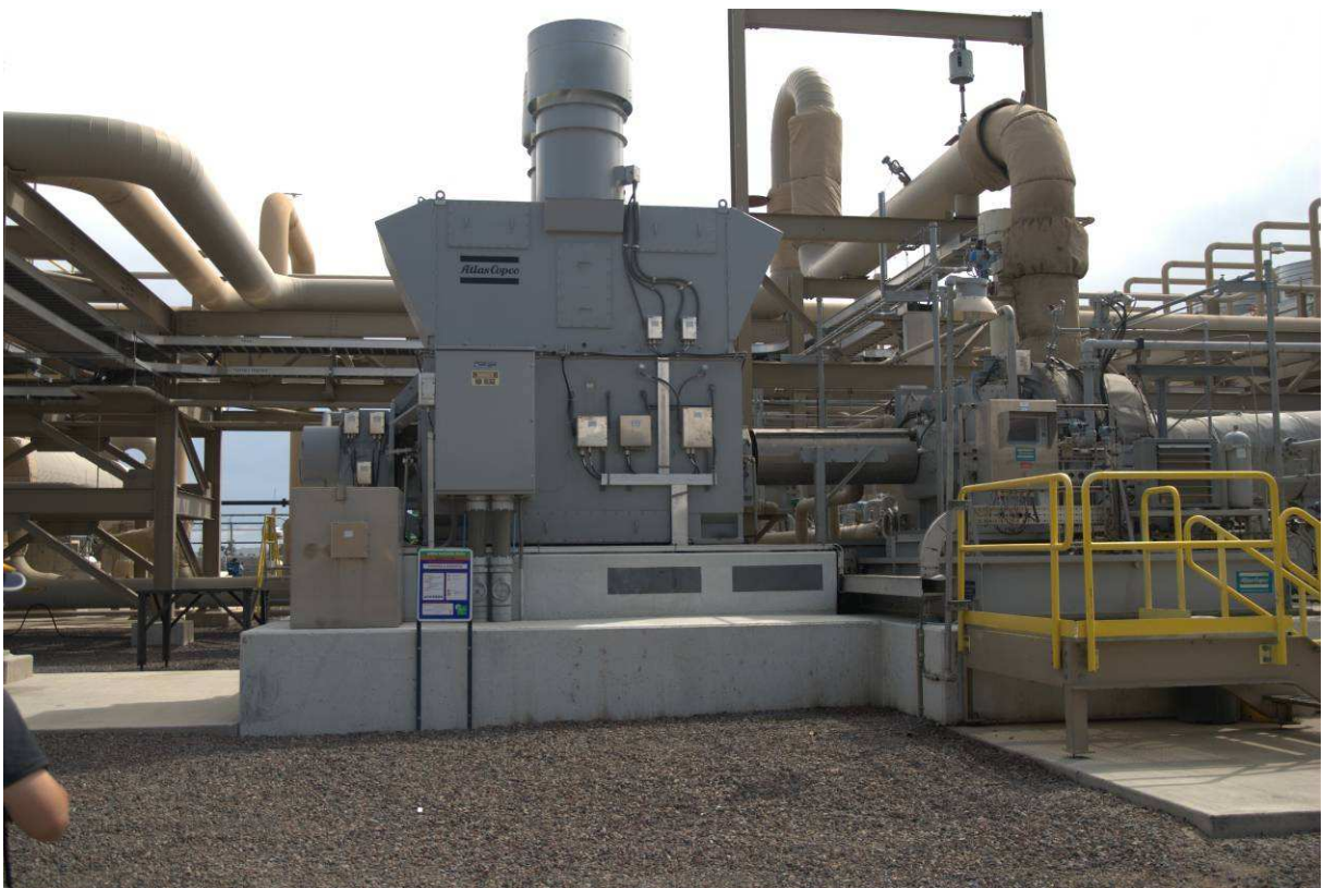
圖11：Stillwater地熱電廠之雙循環發電機
