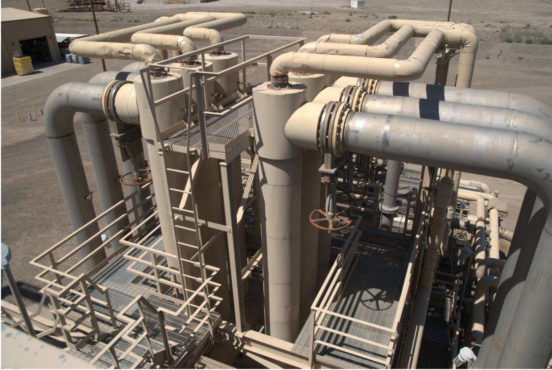
圖17：Dixie Valley地熱電廠之NGT系統
