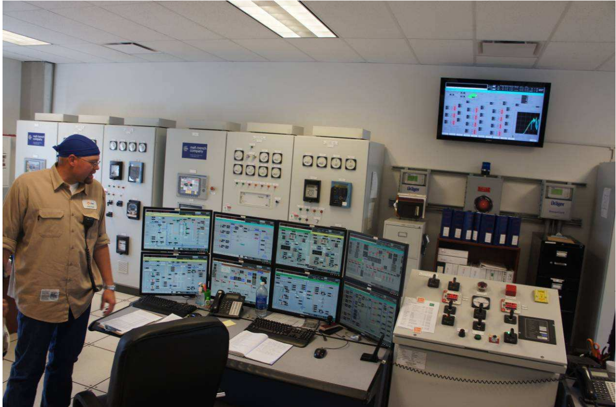
圖14：Stillwater混合式電廠之監控系統
