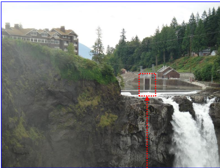
Photo 8. Snoqualmie Fall 地下電廠進水口
