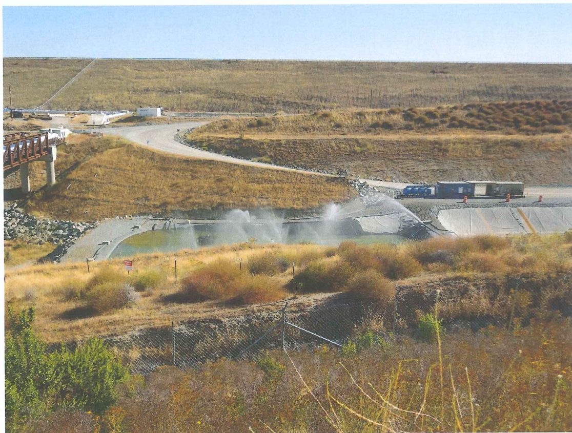
照片 11 Folsom 水庫改善計畫施工照片(二)
