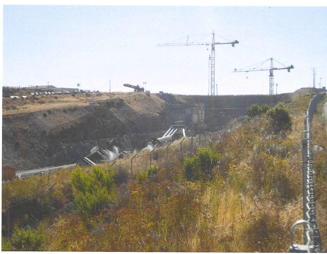
照片 10 Folsom 水庫改善計畫施工照片(一)
