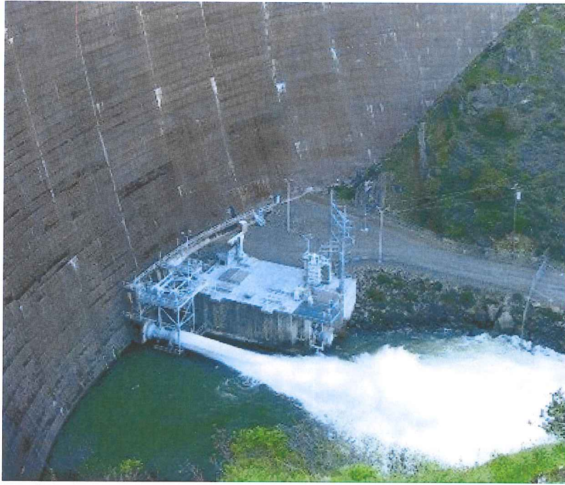
照片 13 Monticello 壩/Glory hole 溢洪道出口
