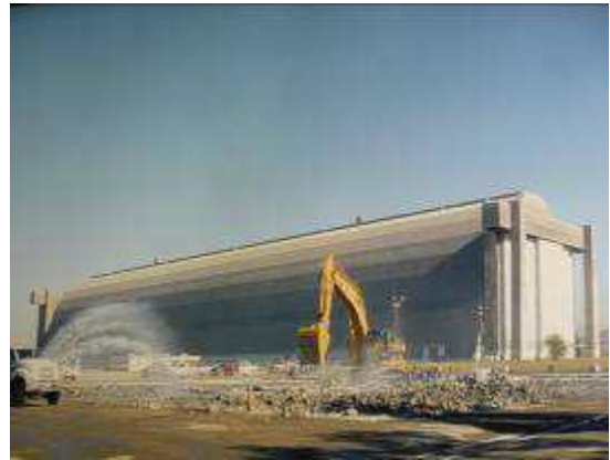
照片 31 Tustin 航空站之場址開挖情形
