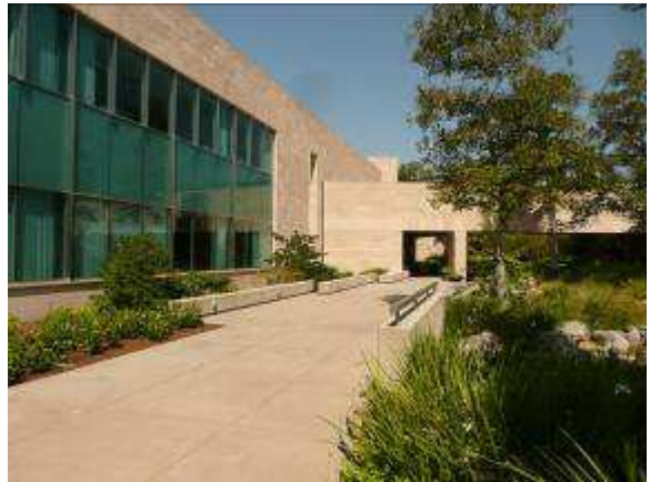
照片 25. MWDOC 建築外觀
