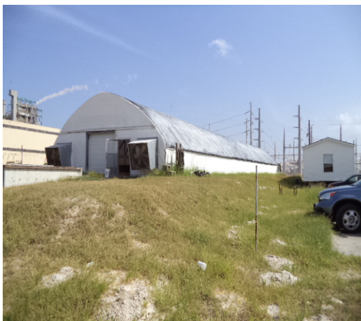
新設生物凝絮渠道式養蝦溫室系統
