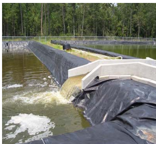
蝦類養殖溫室用沉澱過濾收穫池
