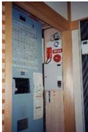
圖 116 自動火災警報設備
