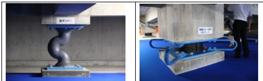
圖 33、34 有明之丘基地下之免震裝置
