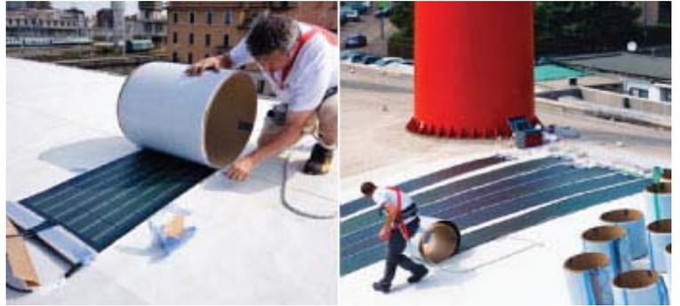
圖五十八、建築型的可撓式 CIGS 太陽能電池
