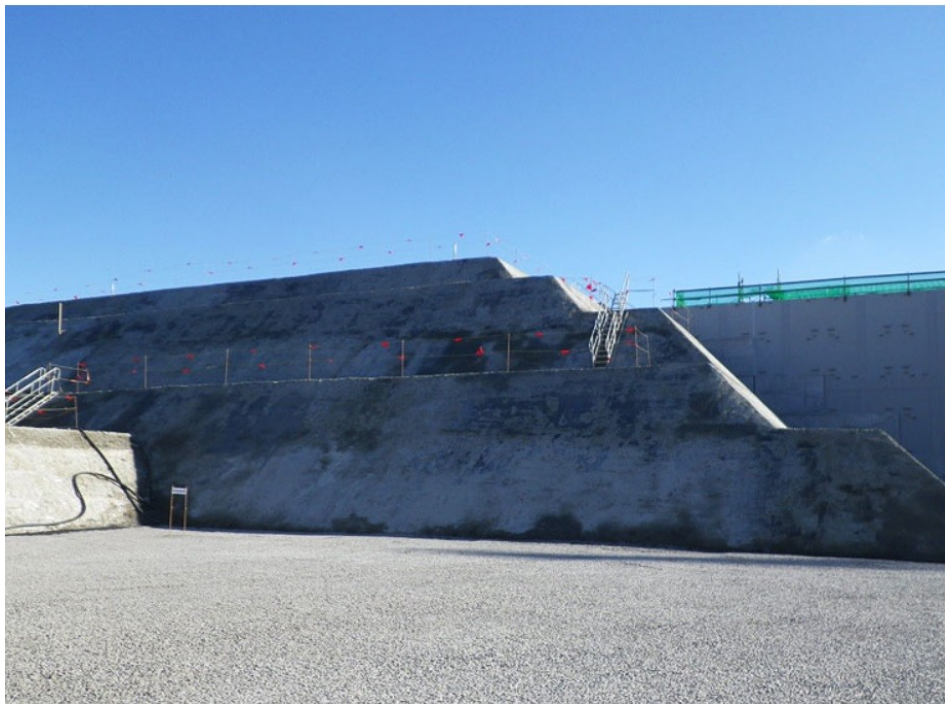
圖八、防海嘯牆西側之水泥強化土堤(摘自網頁)
