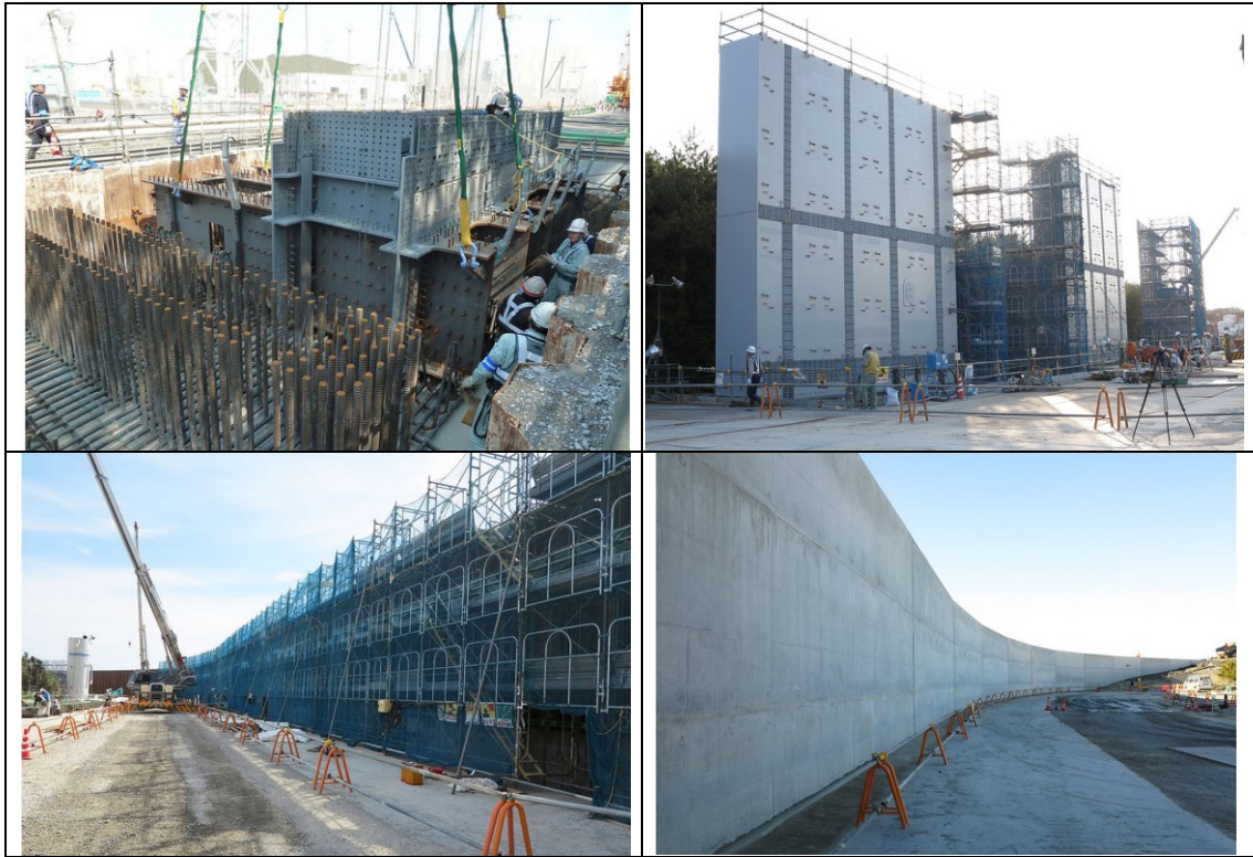
圖七、防海嘯牆施工照片(摘自網頁)
