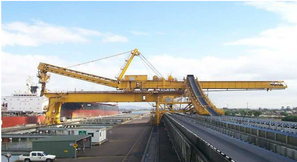
圖(PWCS 裝煤機)
