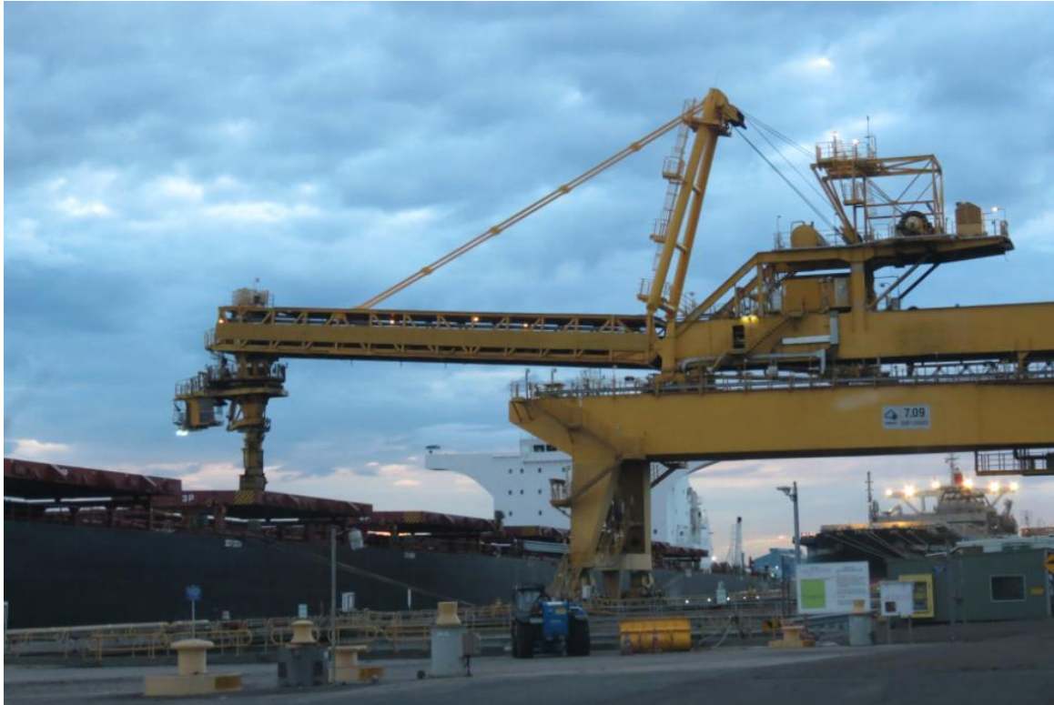
圖69 PWCS Shiploader 裝煤作業
