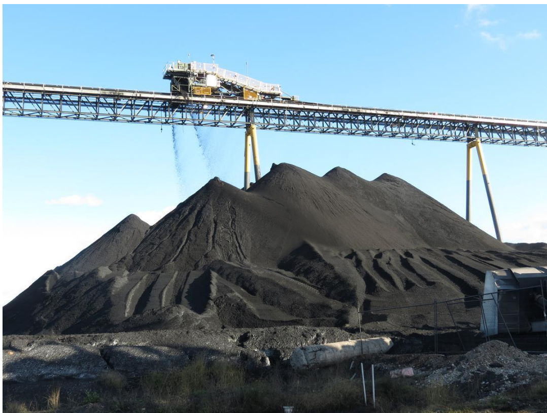
圖30 Narrabri煤礦燃煤儲煤場
