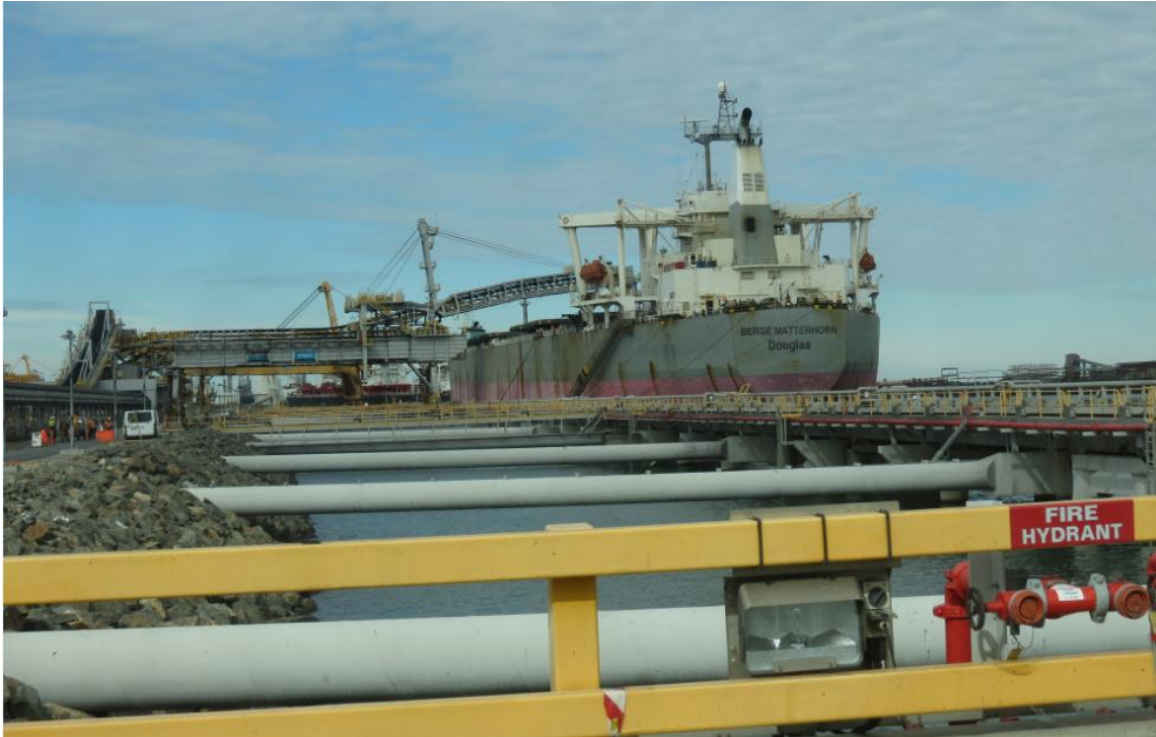
圖87 NCIG Shiploader 1 裝煤作業中
