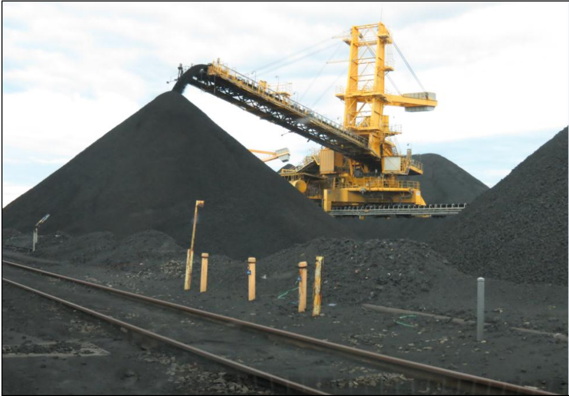
圖59 PWCS 堆煤機(Stacker)堆煤作業
