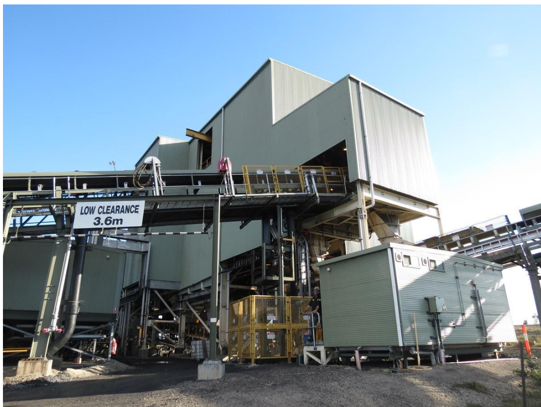
圖39 Narrabri煤礦CHPP外觀
