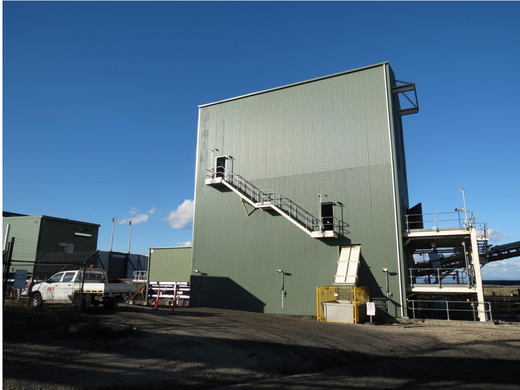
圖28 Narrabri煤礦不洗煤碎煤廠房
