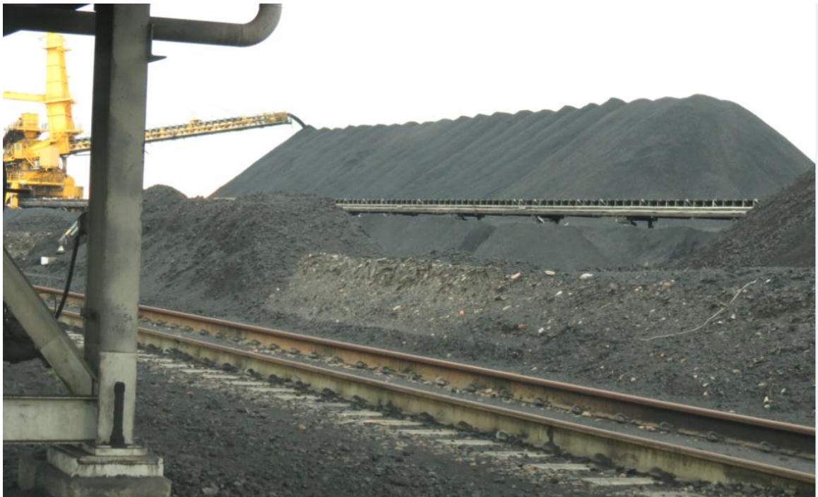
圖58 PWCS 堆煤機(Stacker)堆煤作業
