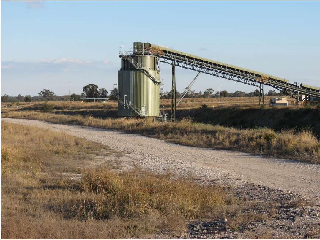
圖46 Narrabri煤礦火車裝煤站
