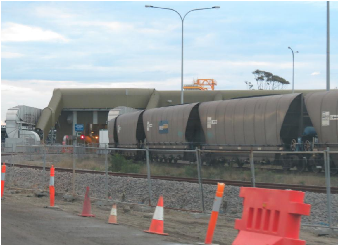
圖56 PWCS 火車卸煤站
