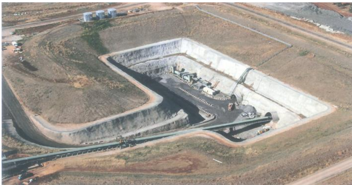
圖26 Narrabri礦區Box Cut (地下礦區出入口)
