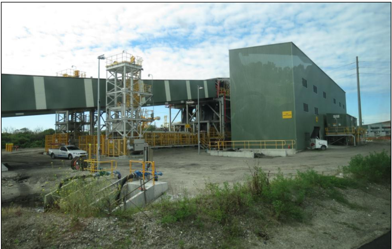
圖78 NCIG 火車卸煤後之取樣站
