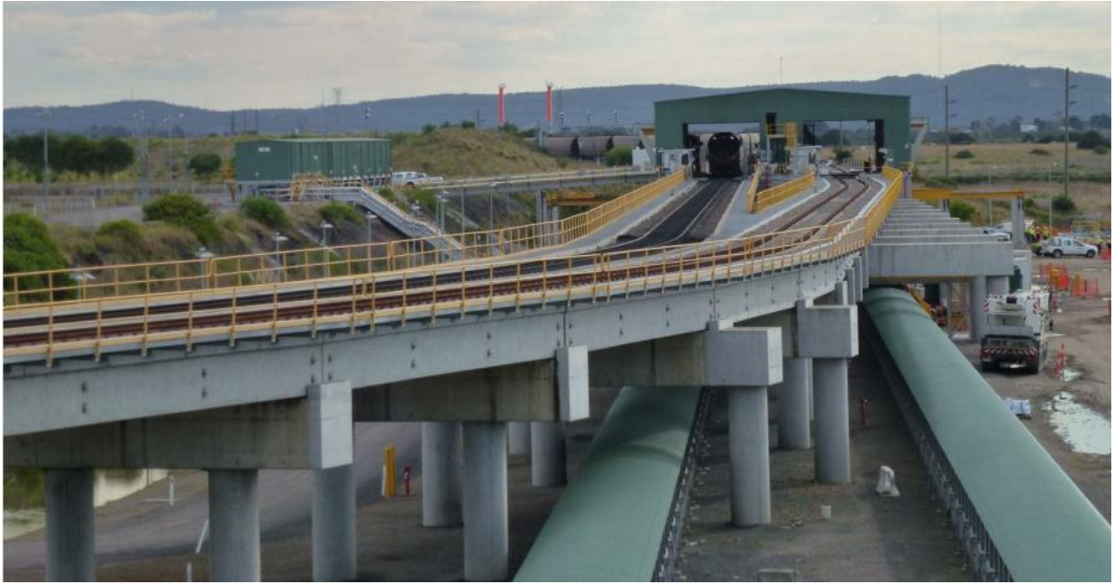
圖75 NCIG火車卸煤站(Rail Unloader)
