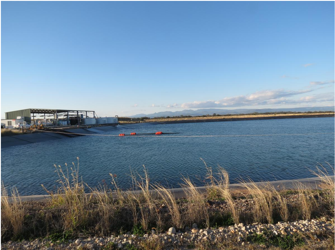
圖47 蓄水壩圖47 運煤火車進入火車迴路
