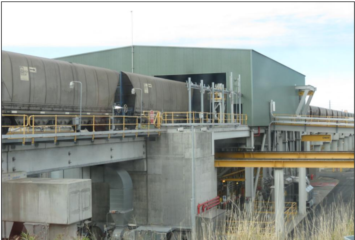
圖76 NCIG 火車卸煤站
