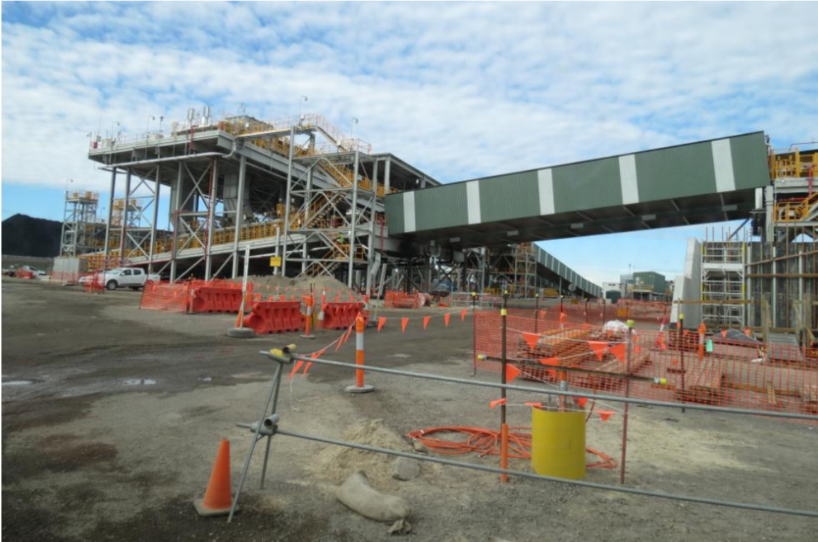
圖85 NCIG 施工中之相關設施(已完成95%)
