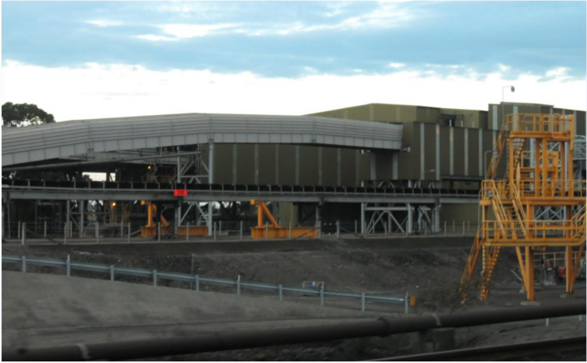
圖55 PWCS 火車卸煤站
