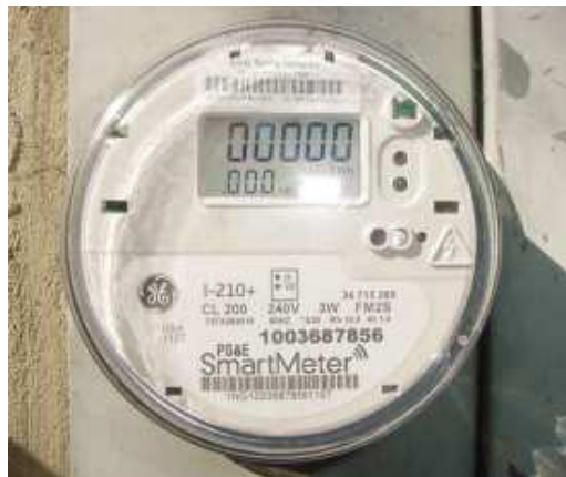
圖 10、PG&E 智慧電表—Smart Meter™
