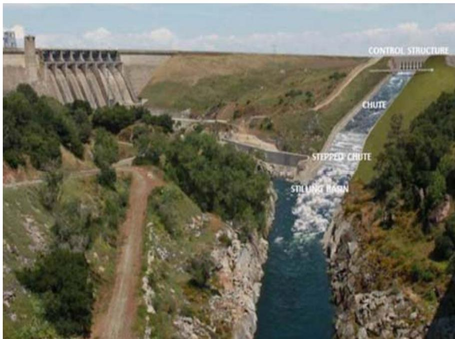
新設輔助溢洪道完工示意圖 資料來源：墾務局簡報資料
